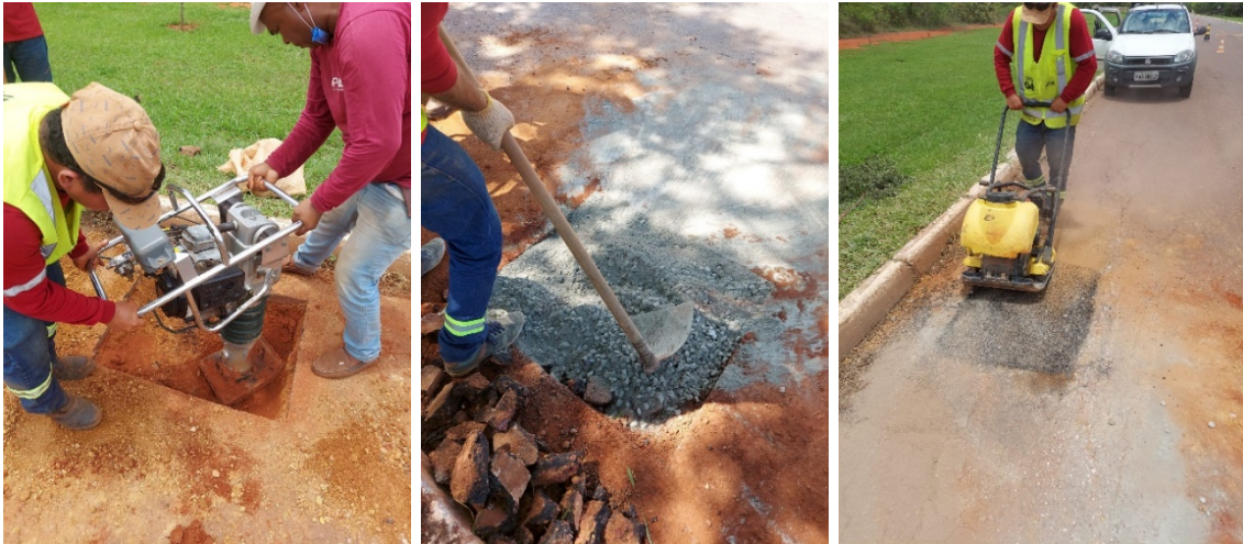
Figura 21. Fechamento de janela de inspeção
