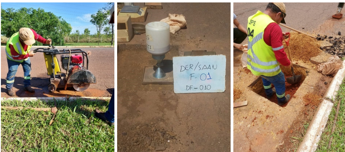
Figura 20. Abertura de janela de inspeção
