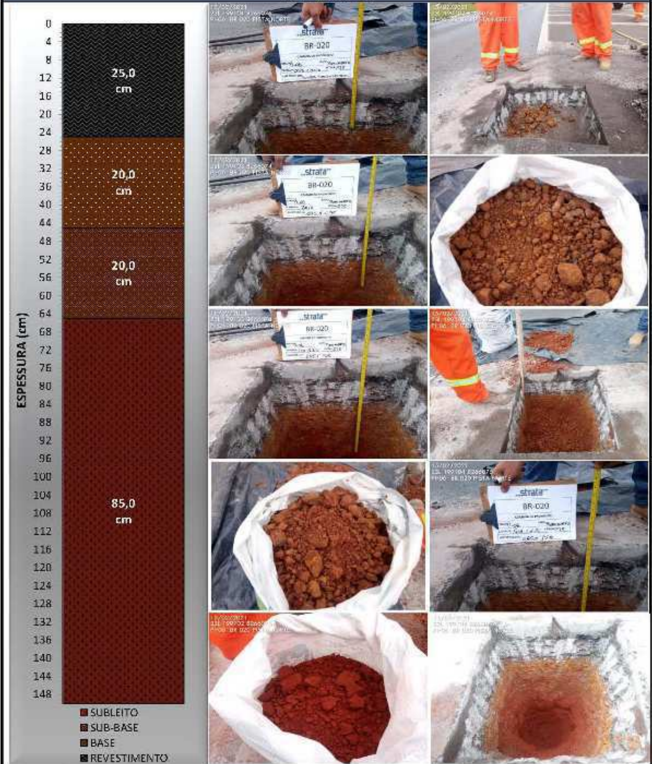
Figura 10: Relatório Fotográfico – PI-06 (Pista Norte)
