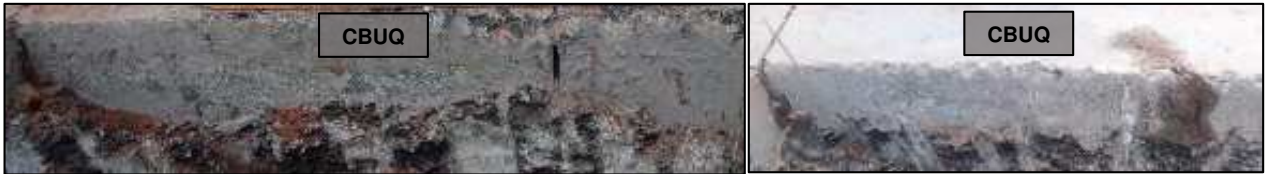
Figura 48 e 49: Camada de Revestimento - PI-08 (Est. 375) E PI-02 (Est. 75)
