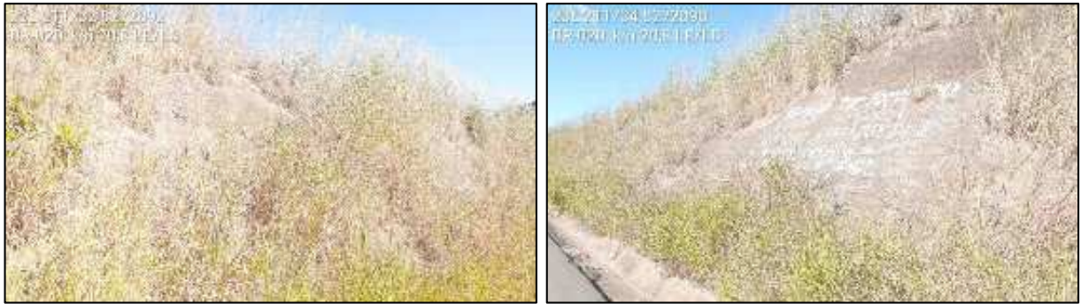
Figura 65 e 66: Material de 2ª Categoria no km 20,8
