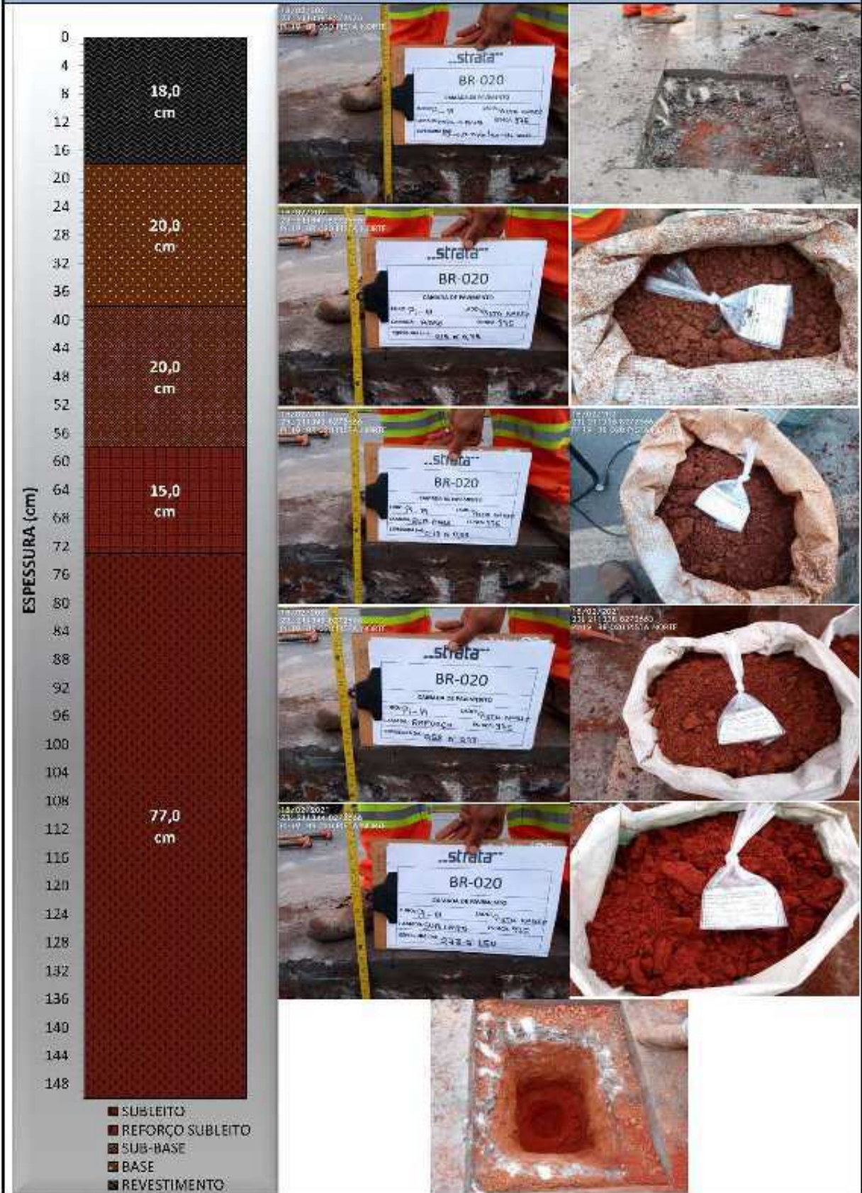
Figura 23: Relatório Fotográfico – PI-19 (Pista Norte)
