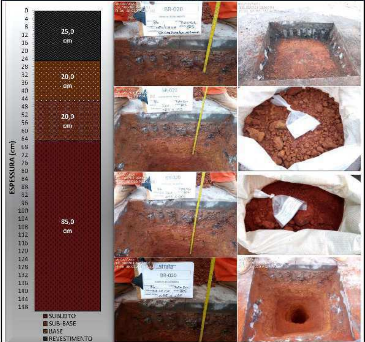
Figura 40: Relatório Fotográfico – PI-36 (Pista Sul)
