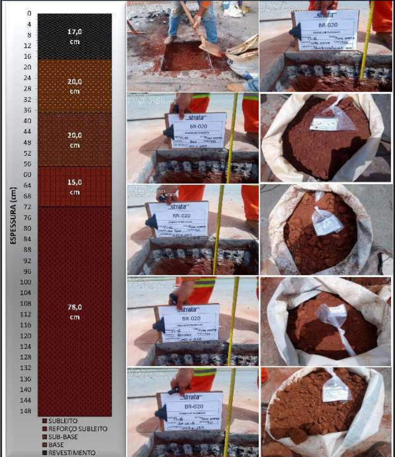
Figura 19: Relatório Fotográfico – PI-15 (Pista Norte)
