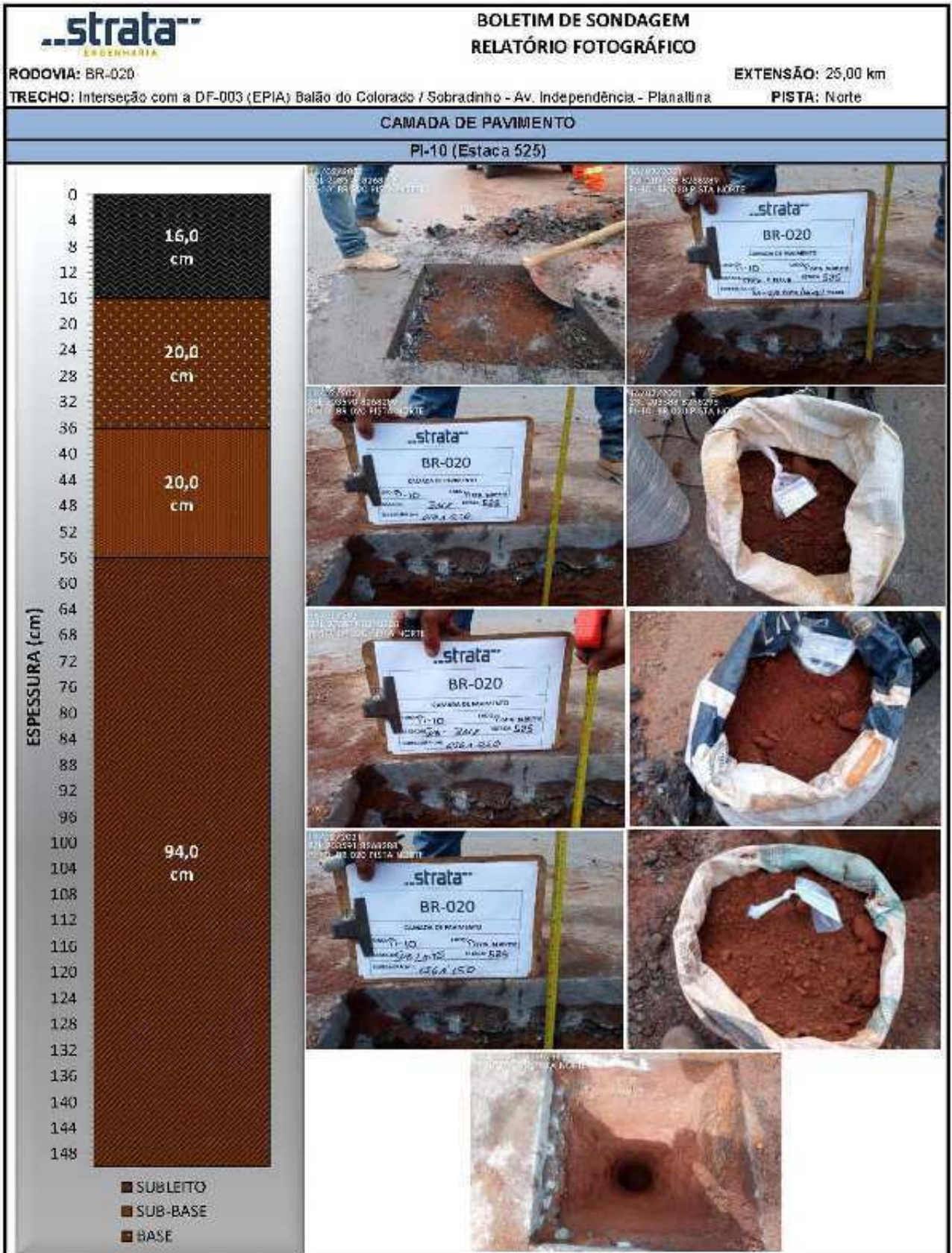
Figura 14: Relatório Fotográfico – PI-10 (Pista Norte)
