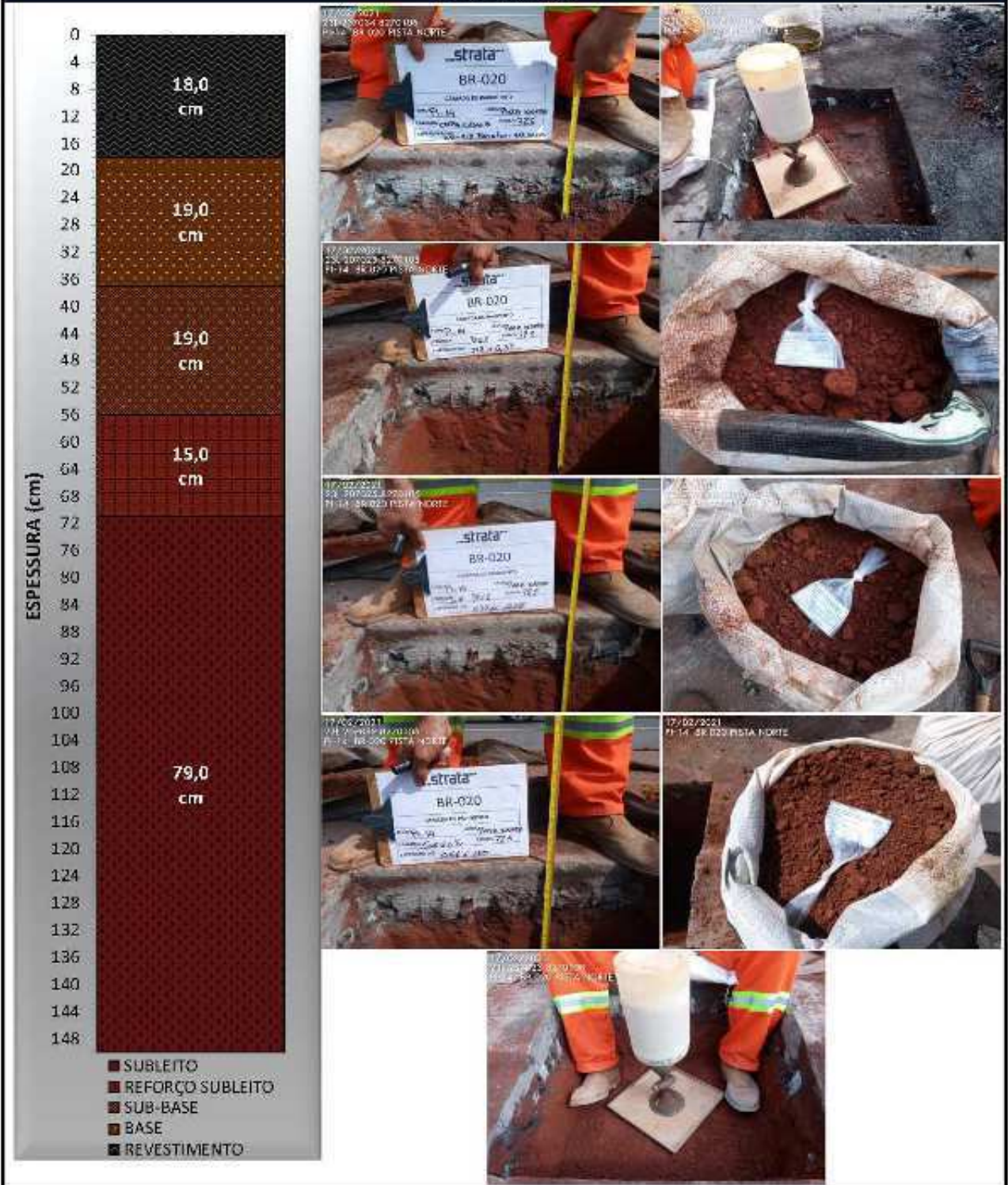
Figura 18: Relatório Fotográfico – PI-14 (Pista Norte)
