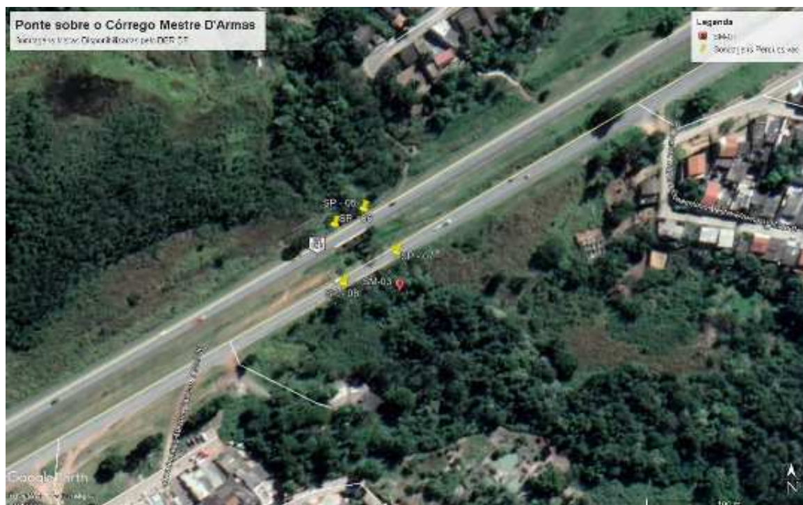
Figura 99 – Alocação das sondagens executadas próximo ao Córrego Mestre D’Armas.
