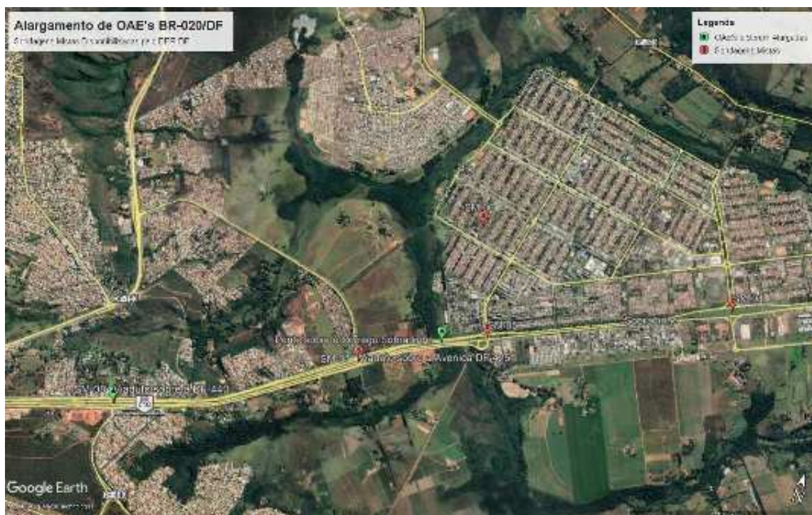
Figura 98 – Alocação das sondagens mistas executadas para o Projeto do BRT, central às pistas de rolamento, próximas a Sobradinho.
