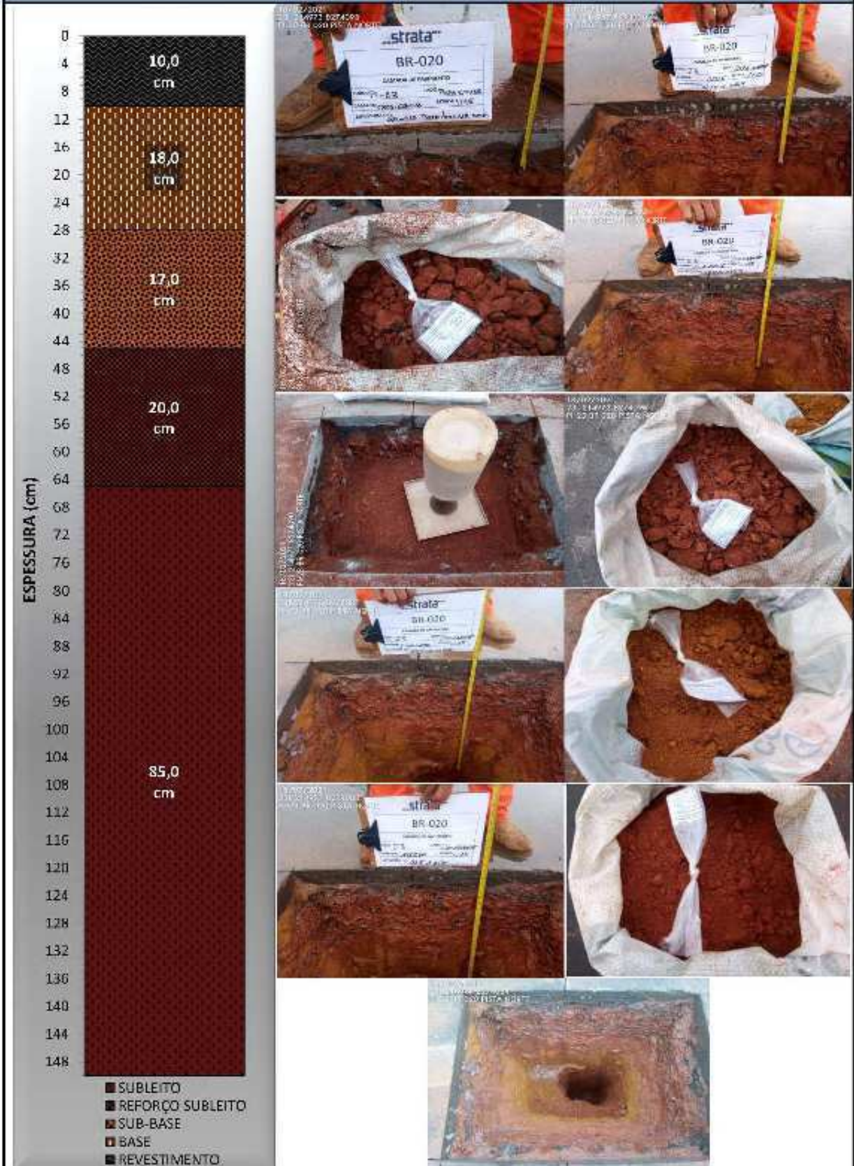
Figura 27: Relatório Fotográfico – PI-23 (Pista Norte)
