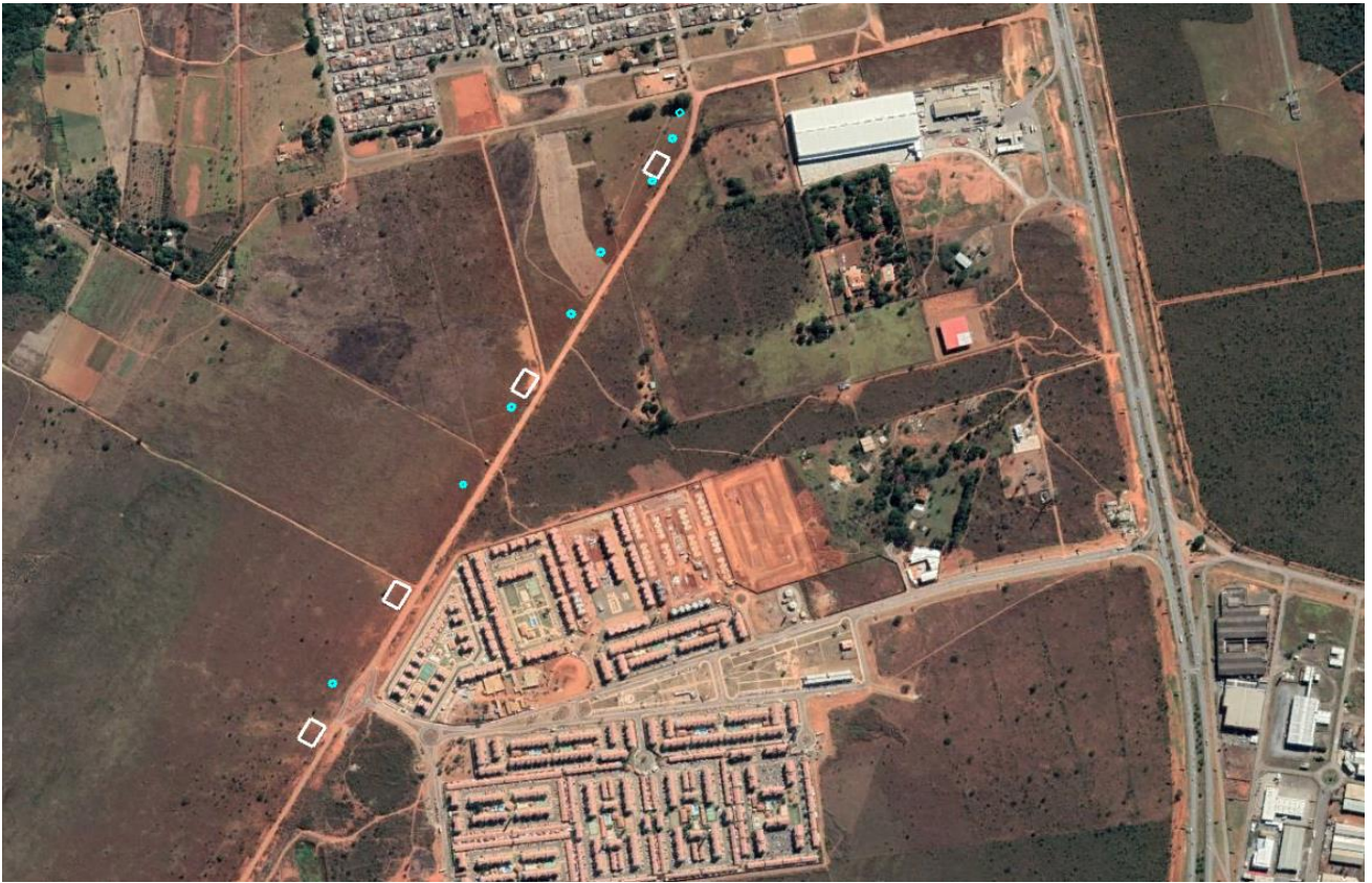
Figura 13: Vista aproximada das bacias. "Trecho 1".
