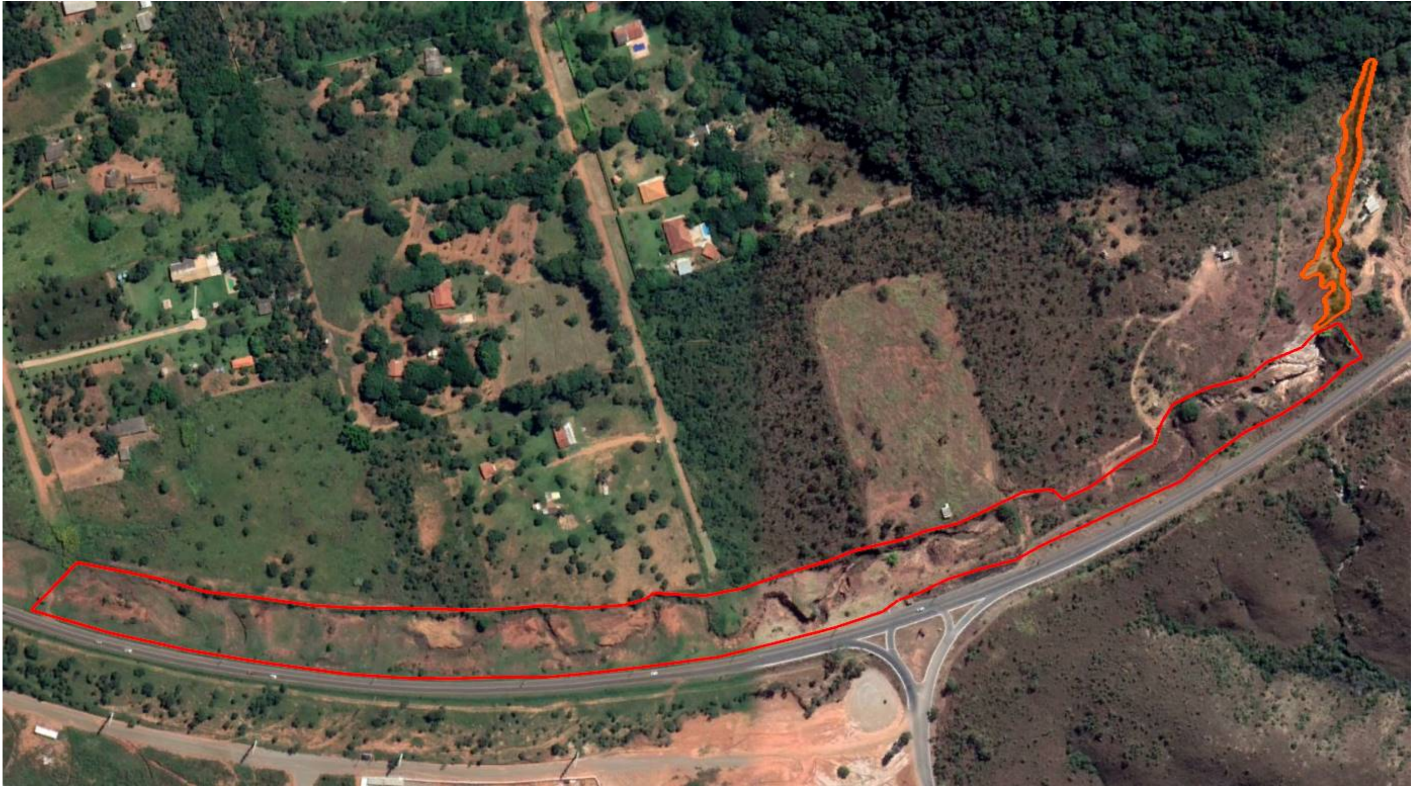
Figura 5: Poligonal da voçoroca já contemplada nos estudos anteriores (em vermelho) a ser recuperada com implantação da drenagem da rodovia DF 250 e novo trecho de voçoroca (em laranja) cujo projeto será detalhado.
