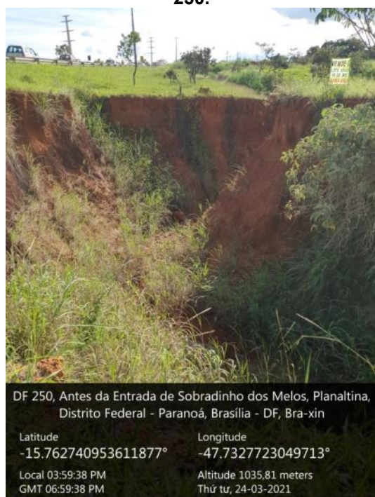
Figura 6: Vista da voçoroca ainda em evolução, na porção mais íngreme da faixa de domínio, e muito próxima à rodovia DF-250.
