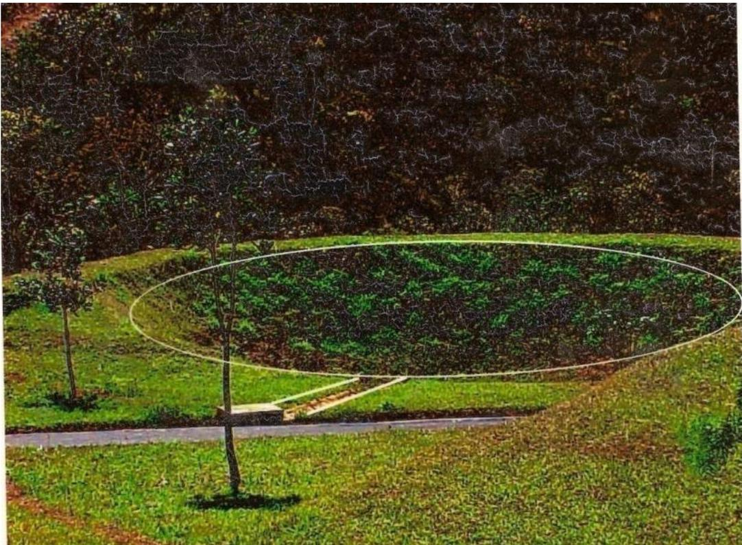
**Figura 3 – Imagem de uma bacia de retenção.**
