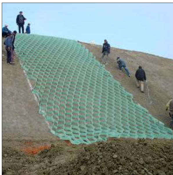
Figura 4 - Aplicação de geogrelha em taludes.
