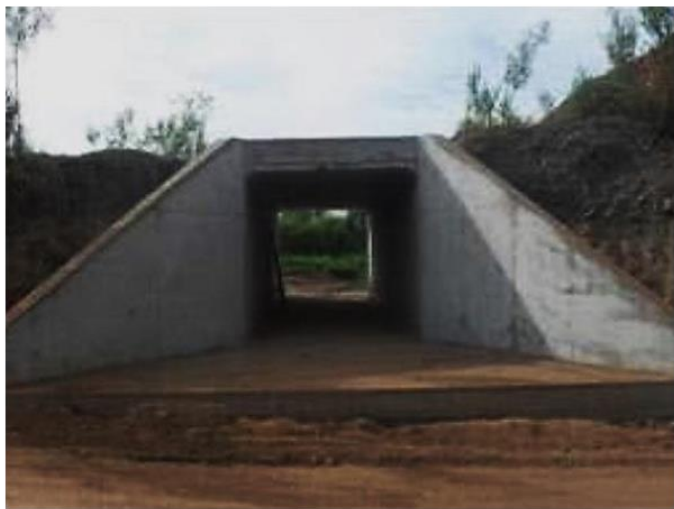
Figura 5 - Passagem de Fauna em Galeria de Concreto 2 X 2 m.
