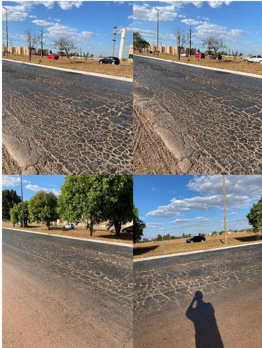
Figura 25: Patologias na Pista Direita – Estaca 16 a 42
