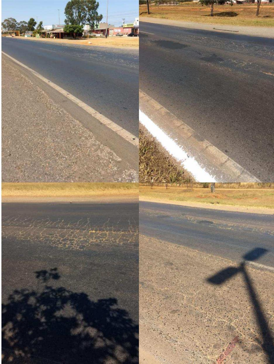
Figura 24: Patologias na Pista Direita – Estaca 4 a 16
