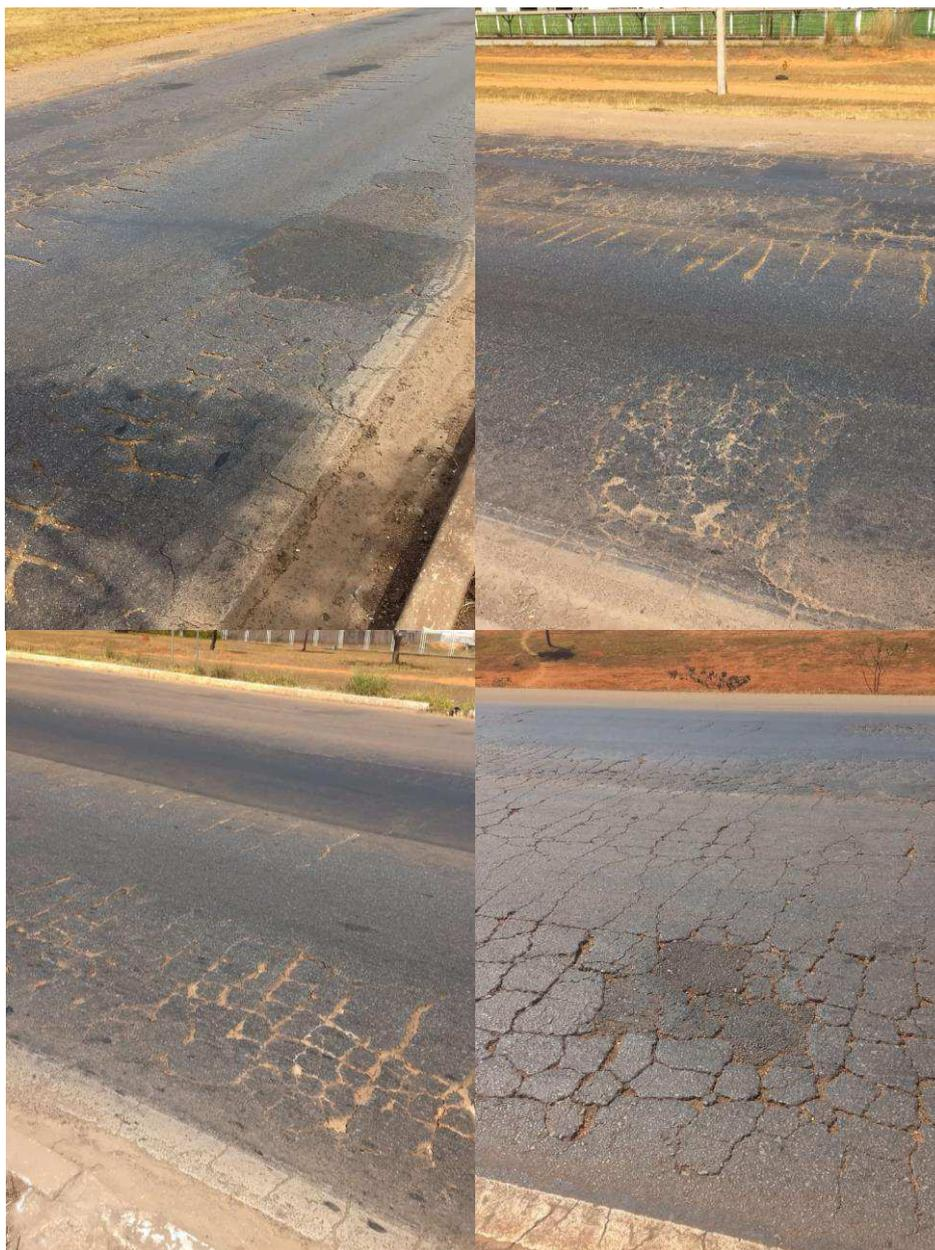
**Figura 26: Patologias na Pista Direita – Estaca 42 a 64**
