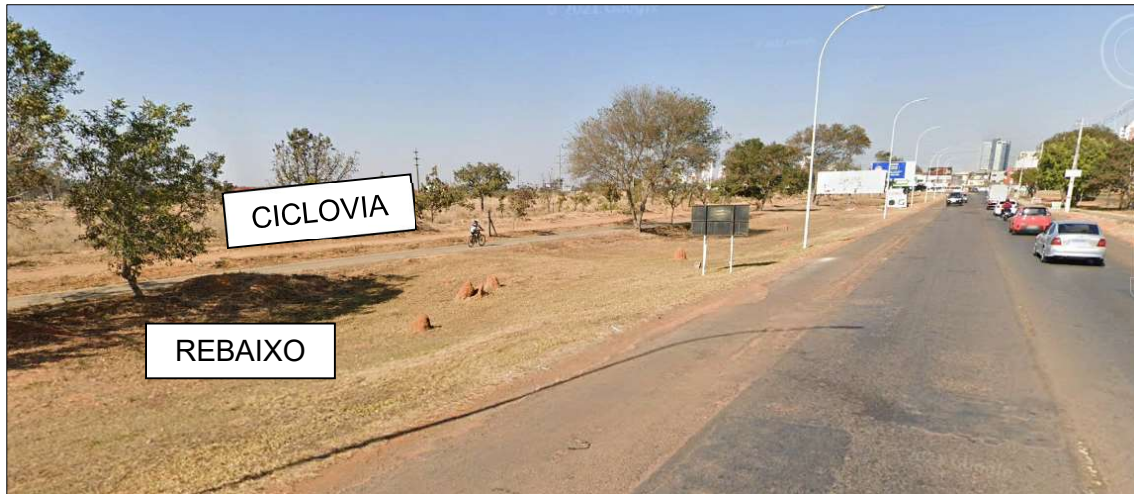
Figura 2: Rebaixo do terreno entre a ciclovia e a DF-460, IFB (Samambaia).
