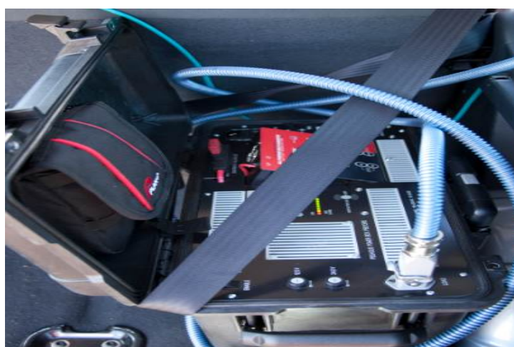
Figura 12 - Bateria de alimentação do sistema
