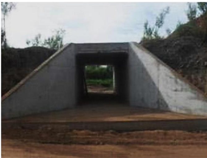
Figura 5 - Passagem de Fauna em Galeria de Concreto 2 X 2 m.
