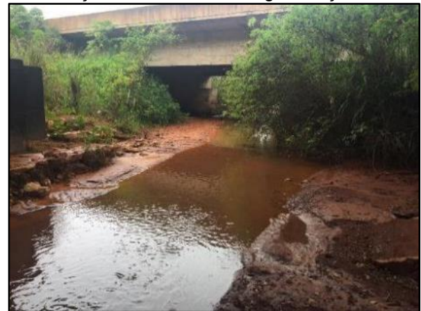
Foto 6: Lançamento final no ribeirão do Torto.
