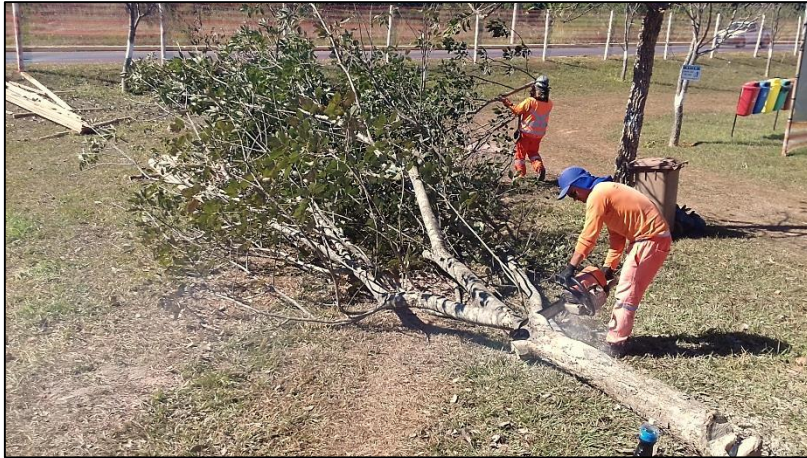
Foto 8: Supressão vegetal ocorrida no trecho em obras.
