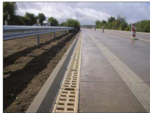
Foto 2: Detalhe de aplicação de canal monobloco de concreto polímero em rodovias.
