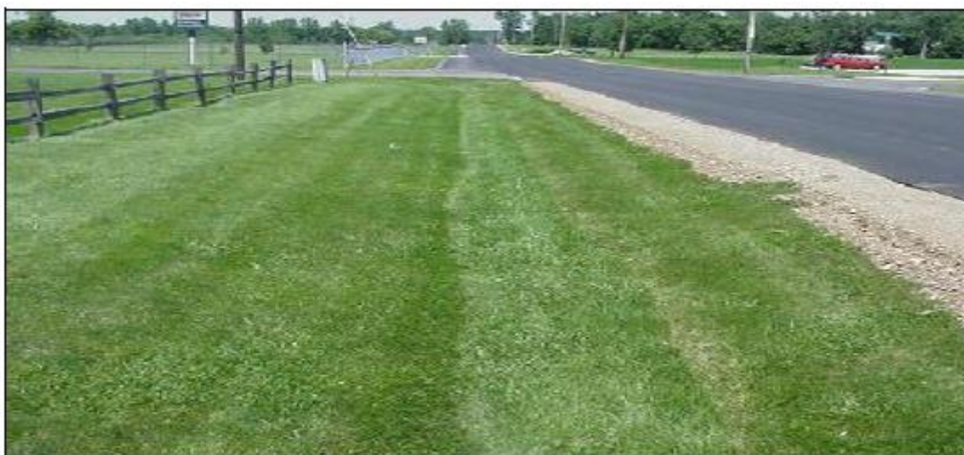
Foto 7: Canal gramado usual a beira de uma estrada em local de baixa densidade habitacional. Fonte: Tomaz, 2009.
