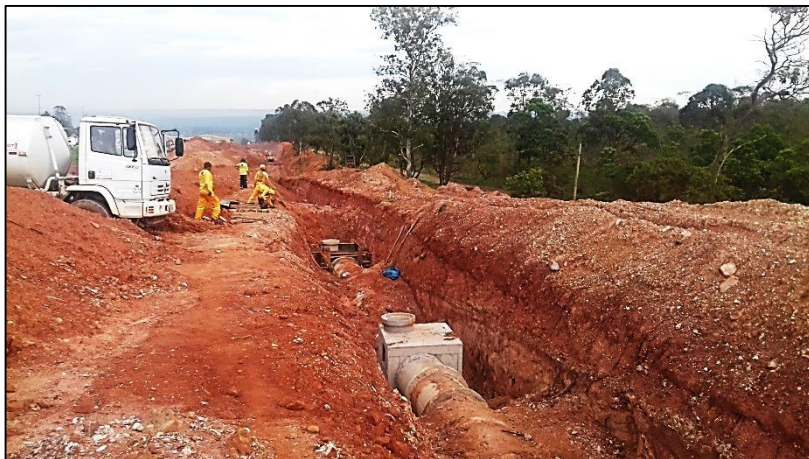
Foto 10: Implantação do sistema de drenagem pluvial.
