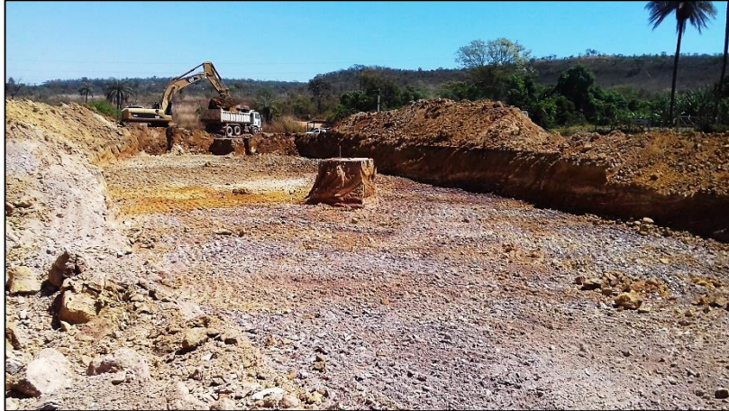
Foto 9: Movimentação de solo para a construção das bacias de drenagem pluvial.
