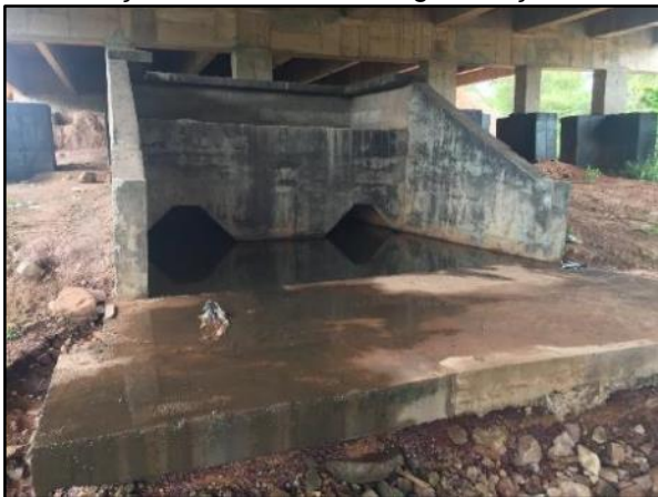
Foto 5: Lançamento final no ribeirão do Torto.
