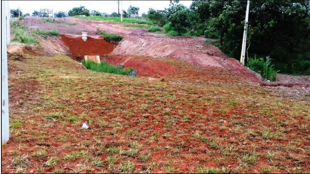
Foto 13: Plantio de grama no entorno da bacia de drenagem – lado viaduto do Torto.
