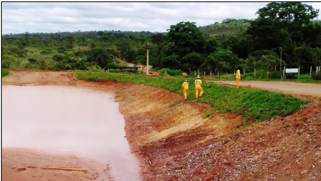
Foto 14: Replântio de grama nos taludes internos das bacias de drenagem – lado viaduto do Colorado.
