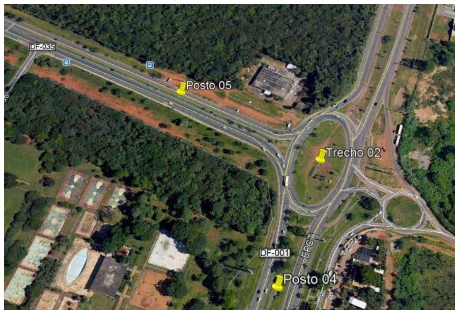
Figura 4: Visualização dos Postos 04 e 05 de Contagem – Trecho 02 – Entroncamento da DF 001/DF 035.
