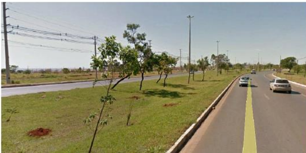
Figura 9 : DF-001 – Trecho com duas faixas de rolamento em cada sentido. Fonte – Google Street View
