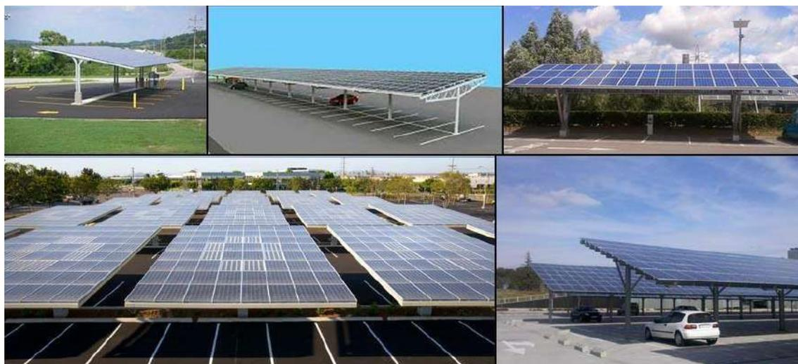
Figura 29: Exemplos de coberturas de veículos com painéis solares (Fonte: Elaboração própria)
