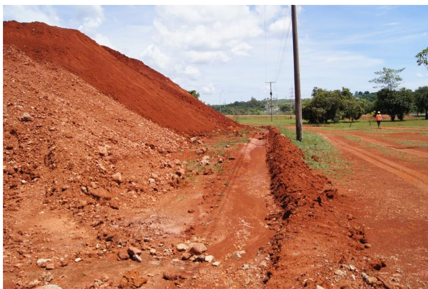
Figura 12 - Área de bota espera localizada próximo ao canteiro de obras.
