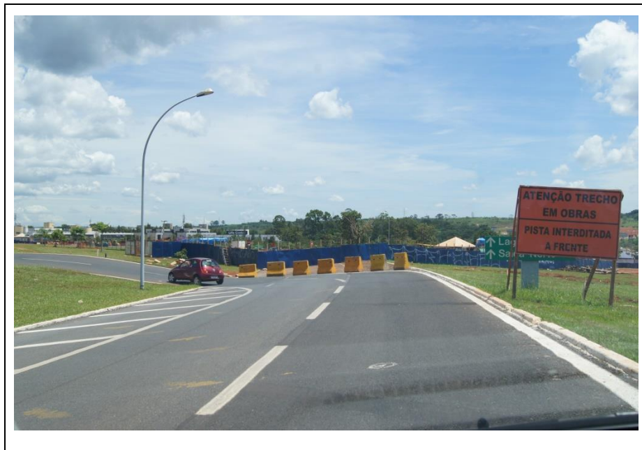
Figura 6. Exemplo de sinalização na implantação de desvios no empreendimento.
