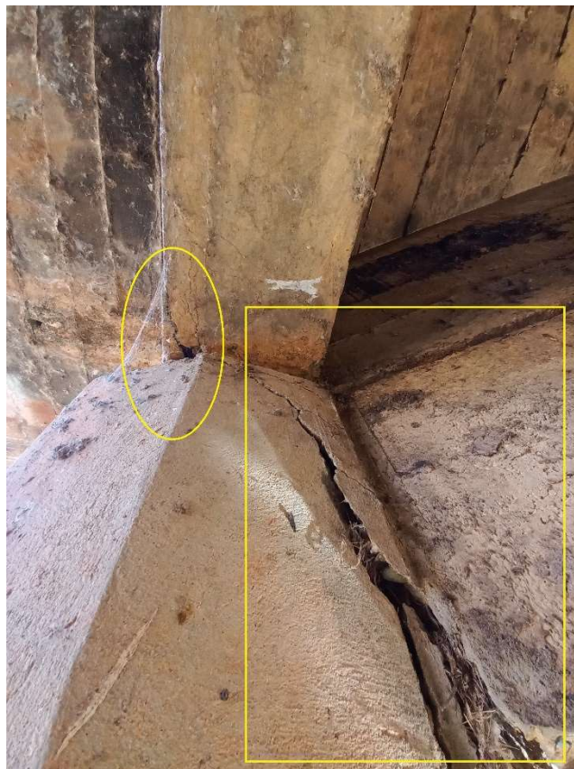
Fotografia n.º 63 – evidenciando plastificação, armaduras aparentes, rachaduras na travessa e efeito de cunha/rachaduras no pilar (26/07/2023)
