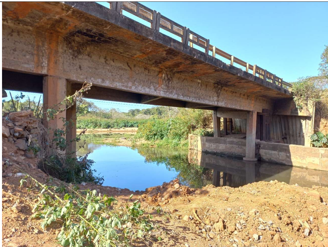
Fotografia n.º 14 – Elevação Parcial Sudoeste (26/07/23)
