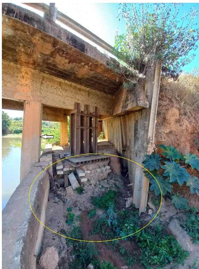
Imagem n.º 97 – croqui indicativo do nível das cheias anuais bem como o efeito da erosão junto ao encontro.
