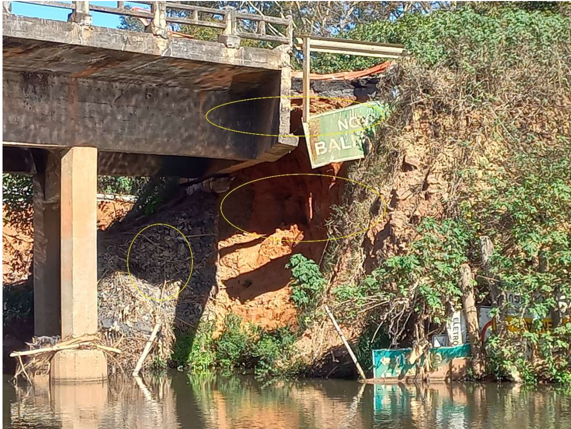
Fotografia n.º 75 – evidenciando ala rompida, colapso do muro de gabião, ala rompida e erosão junto ao encontro (26/07/2023)
