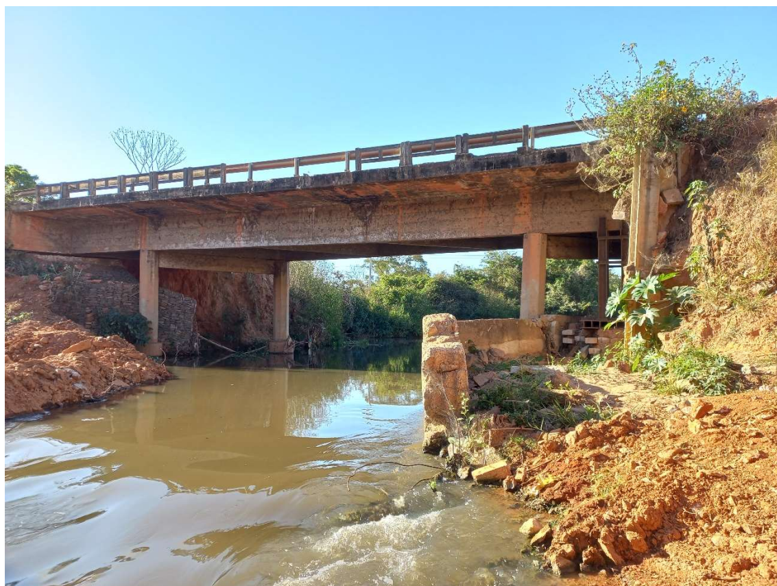
Fotografia n.º 15 – Elevação Parcial Sud0este (26/07/23)
