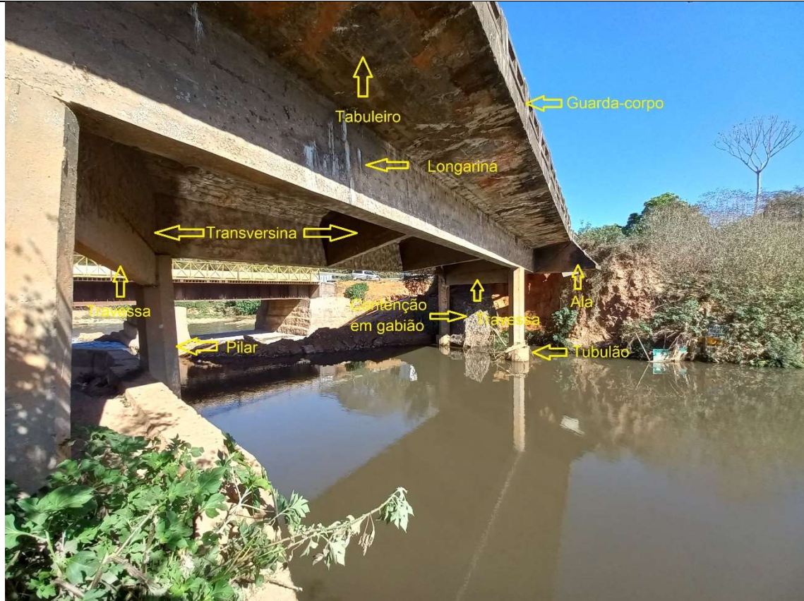
Fotografia n.º 18 – descrição do elementos estruturais, principais, secundários e complementares (26/07/2023)
