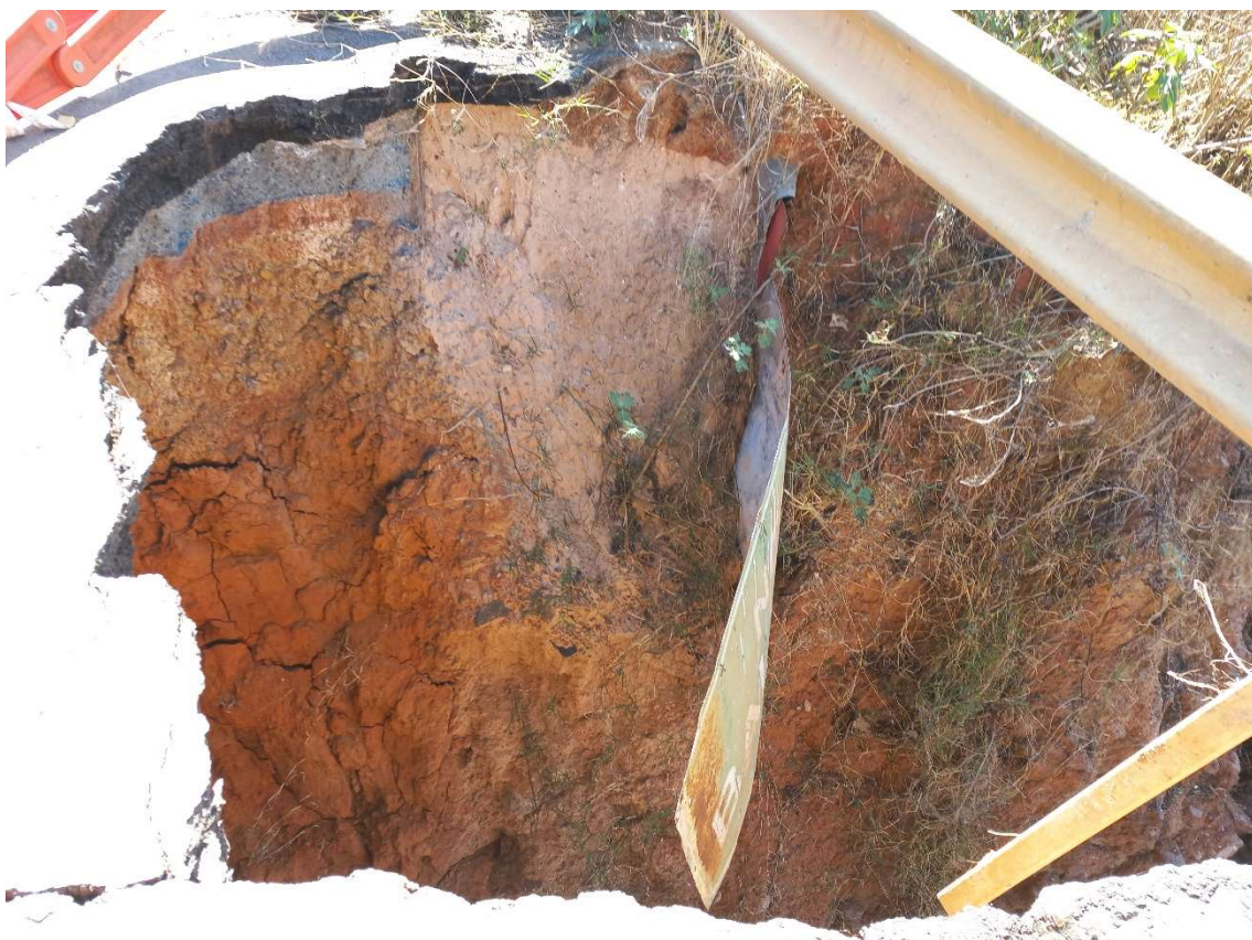
Fotografia n.º 75 – evidenciando ala rompida, colapso do muro de gabião, ala rompida e erosão junto ao encontro (26/07/2023)
