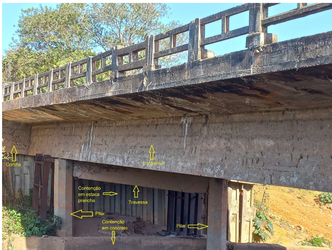
Fotografia n.º 21 – descrição do elementos estruturais, principais, secundários e complementares (26/07/2023)
