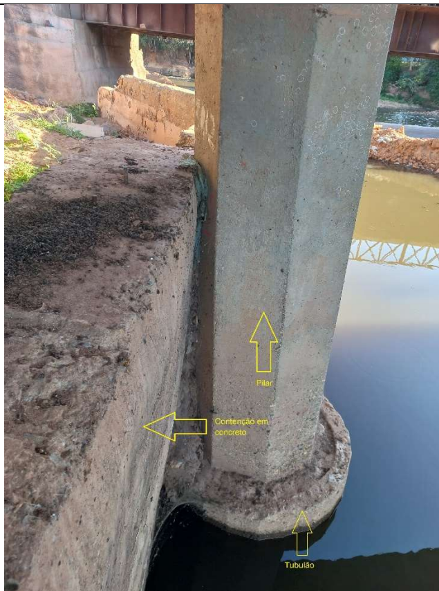
Fotografia n.º 22 – descrição do elementos estruturais, principais, secundários e complementares (26/07/2023)
