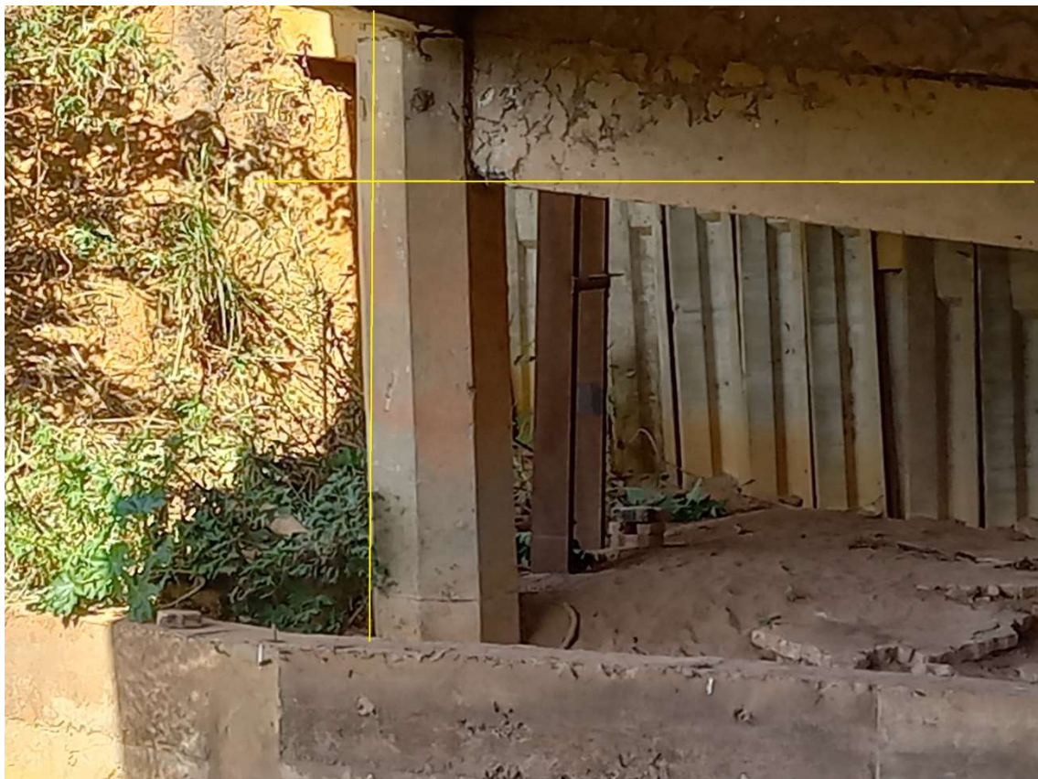
Fotografia n.º 71 – evidenciando desaprumo do pórtico, torção do tabuleiro e recalque do pilar (26/07/2023)
