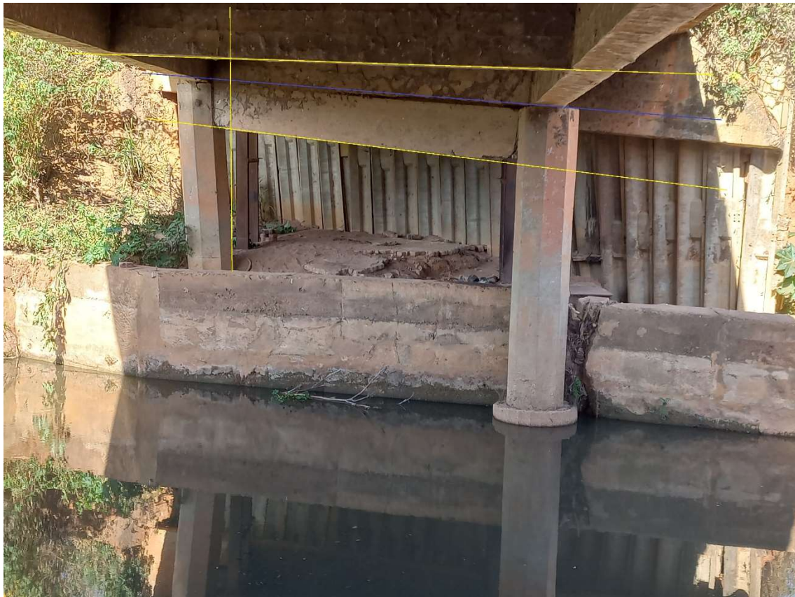
Fotografia n.º 69 – evidenciando desaprumo do pórtico, torção do tabuleiro e recalque do pilar (26/07/2023)
