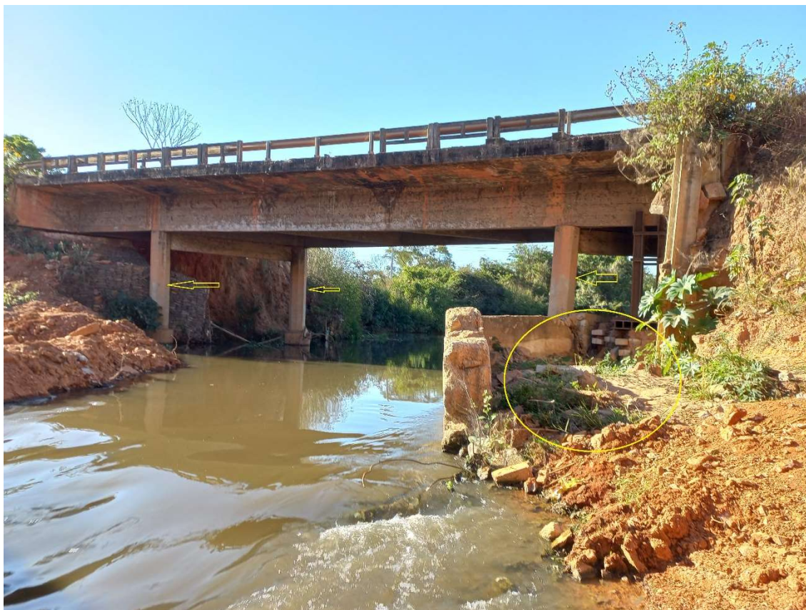
Imagem n.º 98 – croqui indicativo do nível das cheias anuais bem como o efeito da erosão junto ao encontro.
