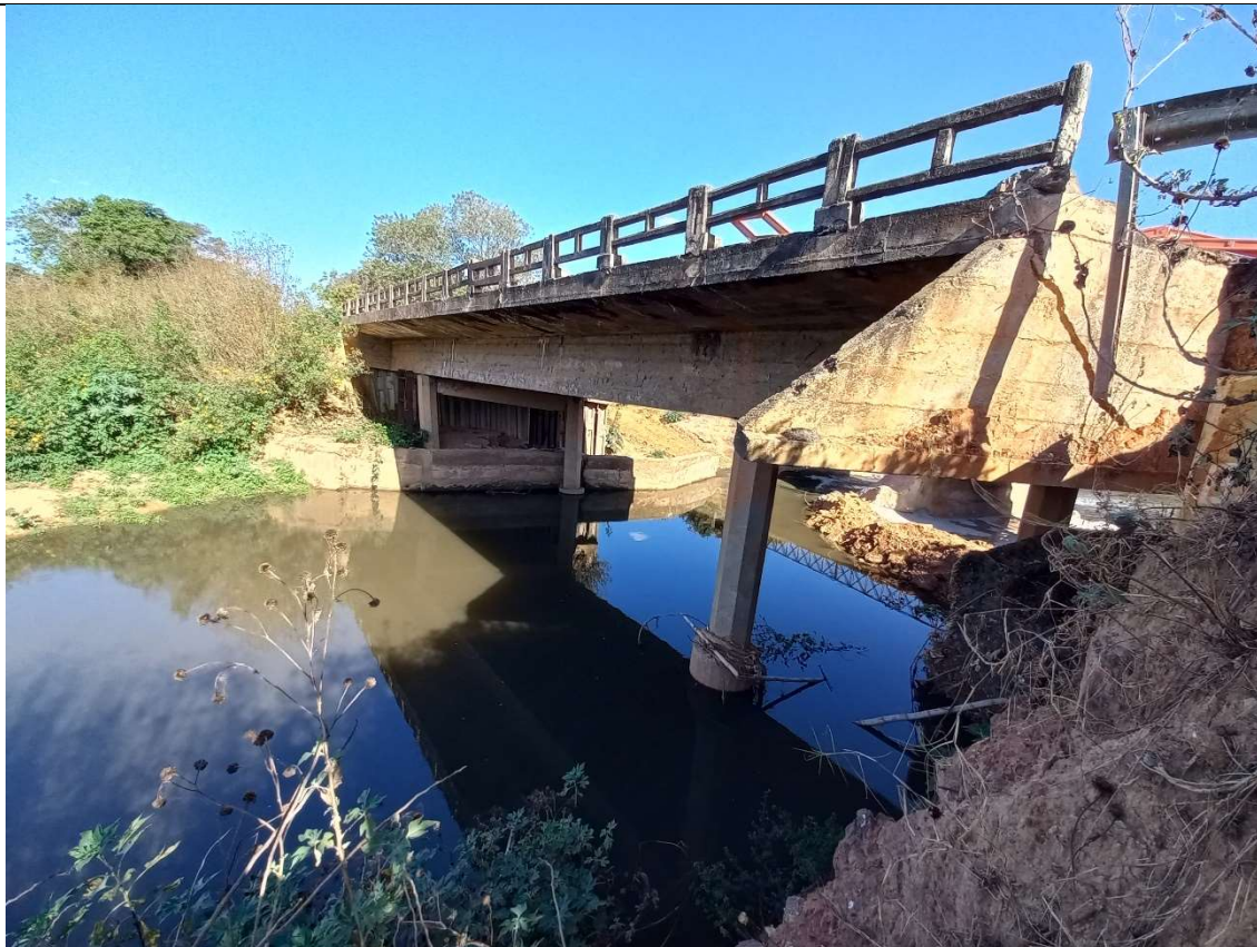
Fotografia n.º 16 – Elevação Parcial Nordeste (26/07/23)
