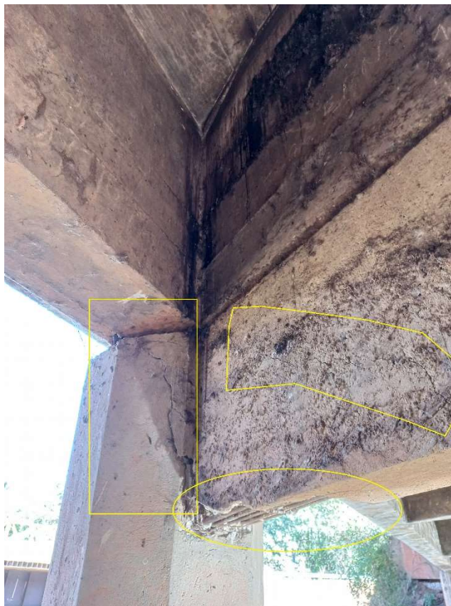
Fotografia n.º 61 – evidenciando plastificação, armaduras aparentes, rachaduras na travessa e efeito de cunha/rachaduras no pilar (26/07/2023)
