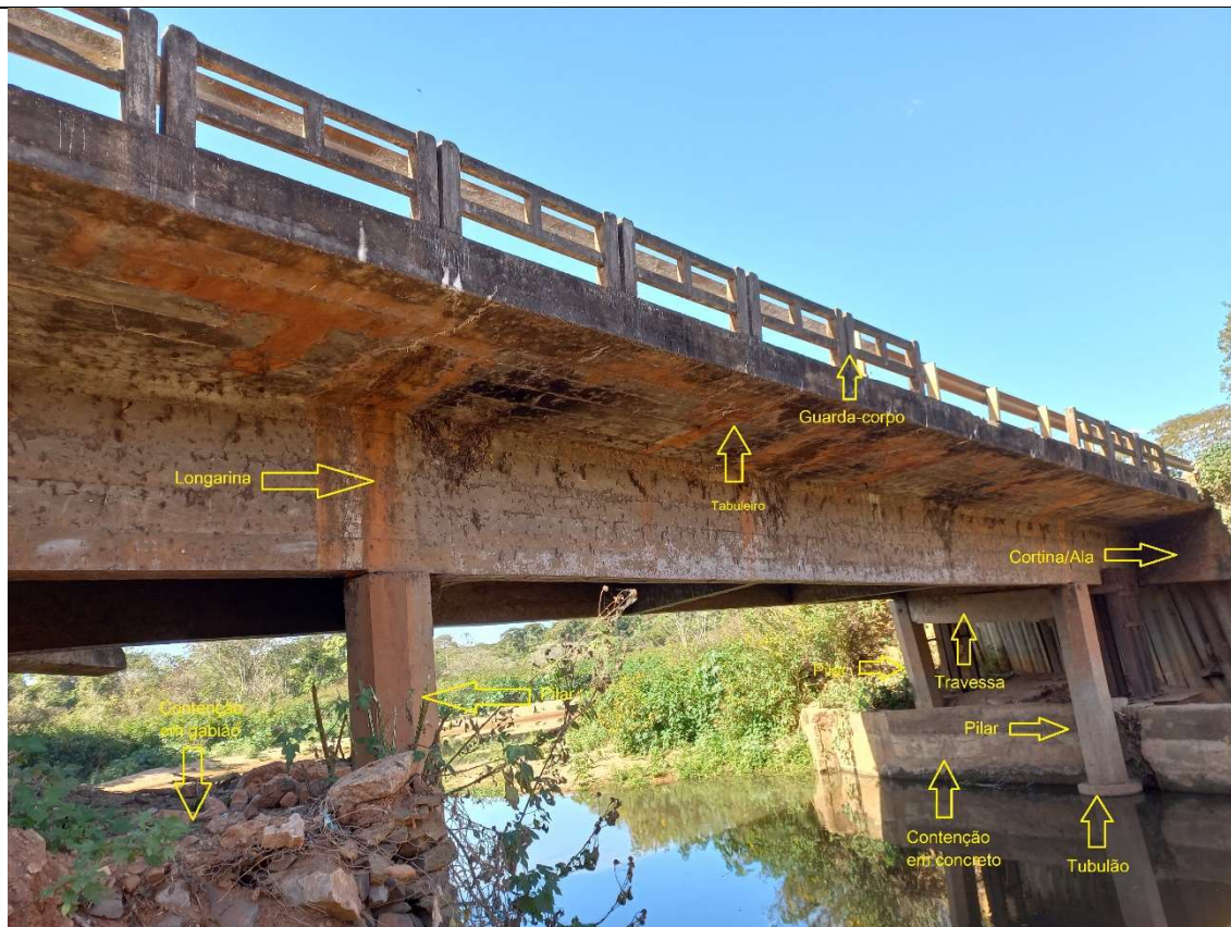
Fotografia n.º 20 – descrição do elementos estruturais, principais, secundários e complementares (26/07/2023)
