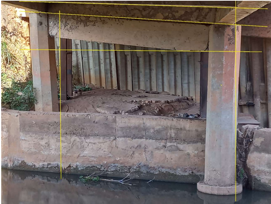
Fotografia n.º 71 – evidenciando desaprumo do pórtico, torção do tabuleiro e recalque do pilar (26/07/2023)
