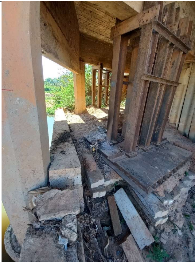
Fotografia n.º 82 – escoramento metálico emergencial executado que mantém a estabilidade da estrutura (26/07/2023)
