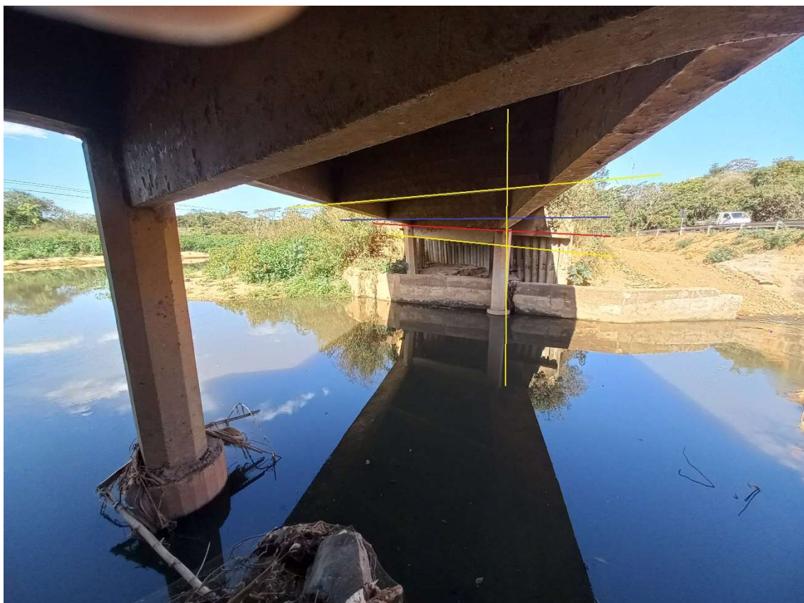
Fotografia n.º 69 – evidenciando desaprumo do pórtico, torção do tabuleiro e recalque do pilar (26/07/2023)
