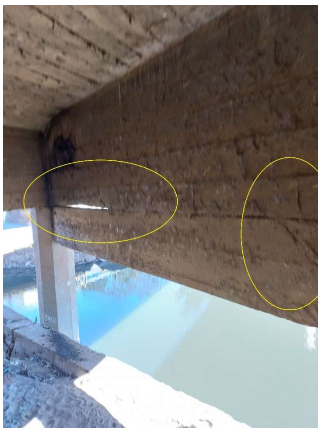
Fotografia n.º 57 – evidenciando desnivelamento, plastificação, rachaduras e perda de função estrutural da travessa (26/07/2023)
