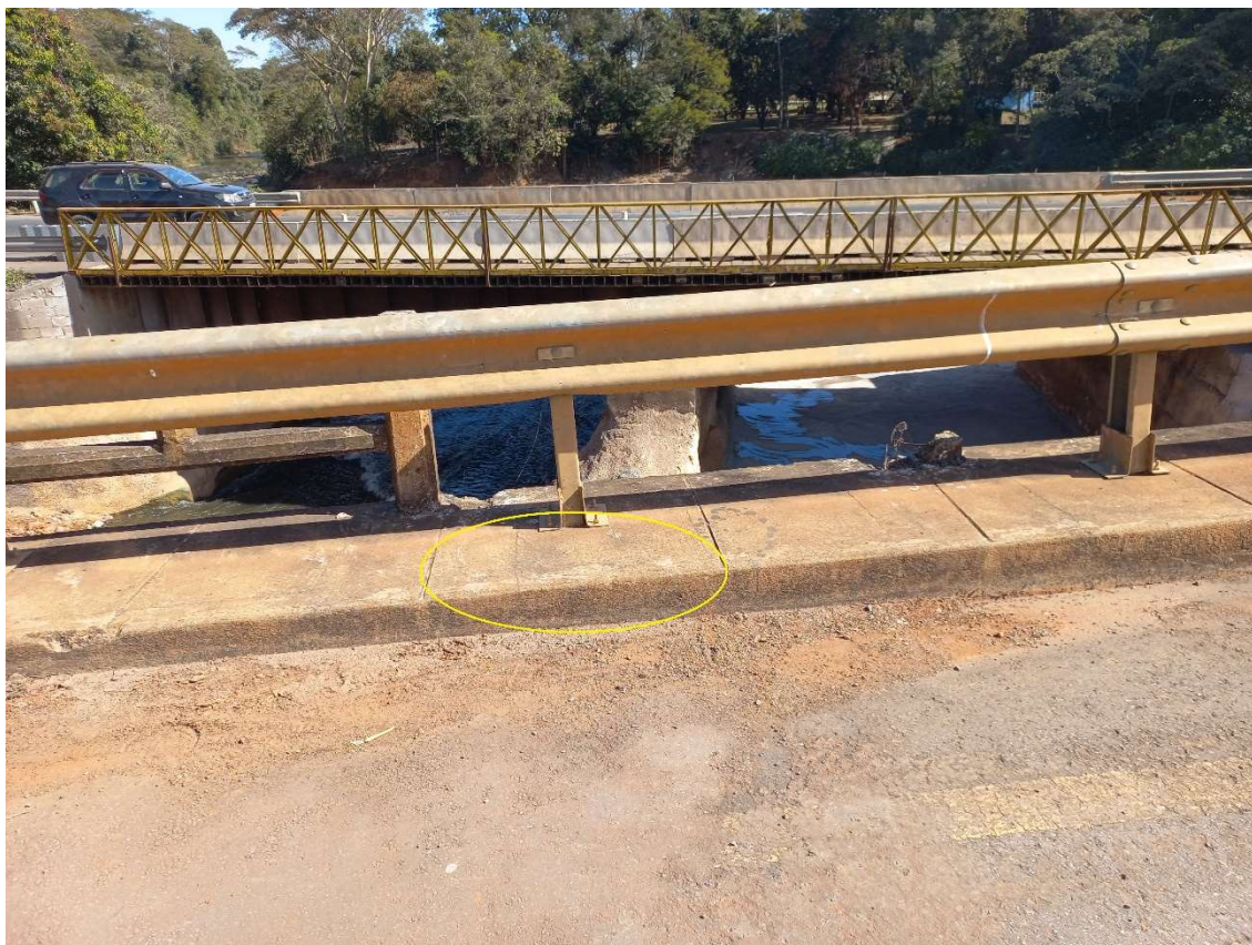
Fotografia n.º 53 – evidenciando largura do passeio (26/07/2023)
