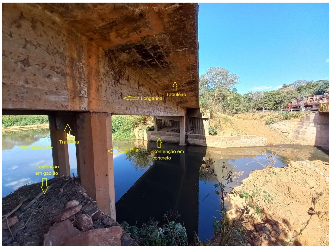
Fotografia n.º 19 – descrição do elementos estruturais, principais, secundários e complementares (26/07/2023)
