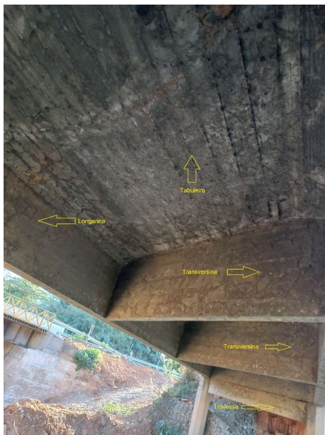
Fotografia n.º 23 – descrição do elementos estruturais, principais, secundários e complementares (26/07/2023)
