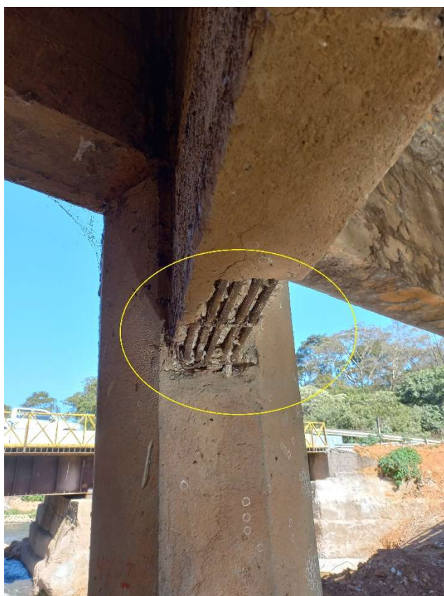
Fotografia n.º 61 – evidenciando plastificação, armaduras aparentes, rachaduras na travessa e efeito de cunha/rachaduras no pilar (26/07/2023)
