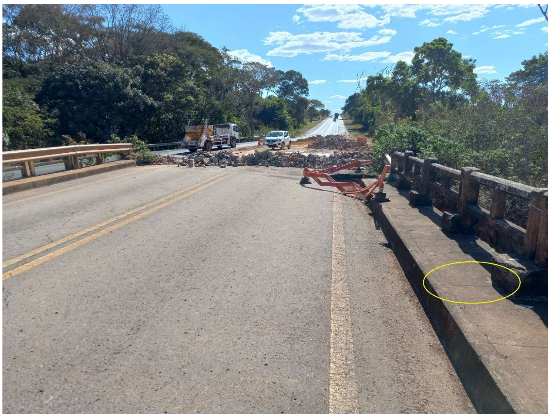
Fotografia n.º 52 – evidenciando largura do passeio (26/07/2023)
