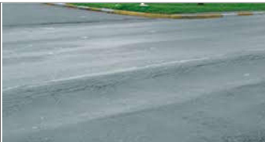
**59 – Nas faixas de tráfego onde apresentar patologia de afundamento de trilha de roda maiores de 50 mm, de acordo com o Projeto de Restauração podem também ser corrigidas, promovendo o nivelamento da superfície, utilizando Concreto Portland com resistência característica à compressão axial simples de 11 MPa. (Fonte: Imagens da Internet)**
