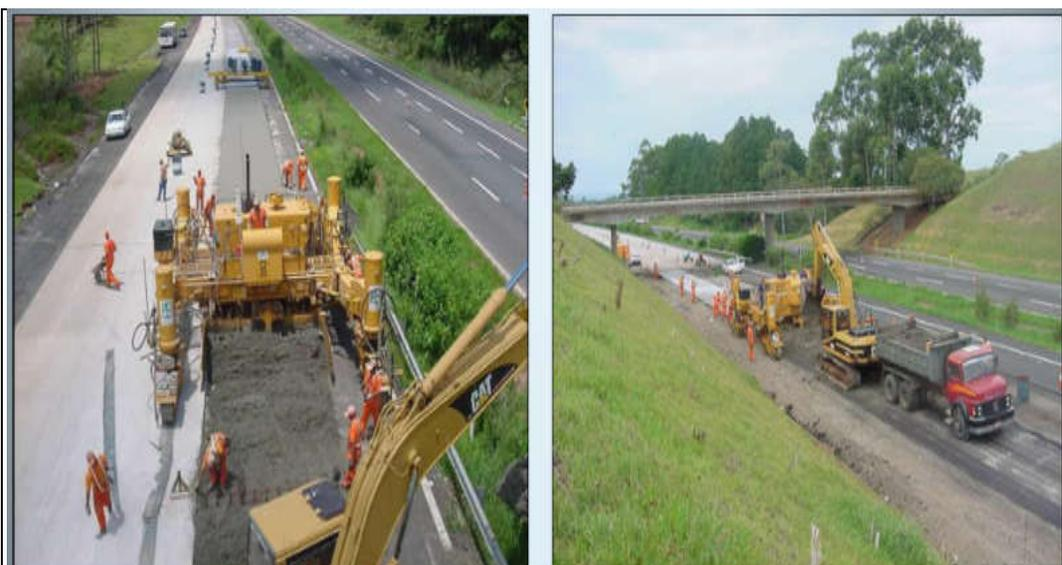
**65 – Execução de camada de concreto sobre o revestimento asfáltico – Whitetopping. (Fonte: Curso: CRG Engenharia/ABCP).**
