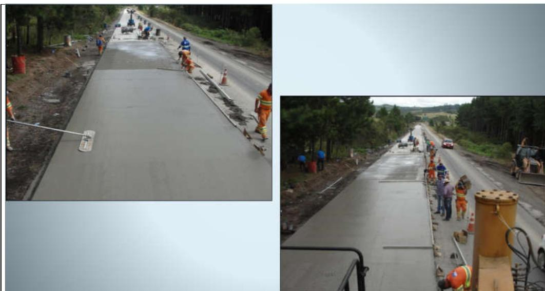
**64 – Execução de camada de concreto sobre o revestimento asfáltico – Whitetopping. (Fonte: Curso: CRG Engenharia/ABCP)**
