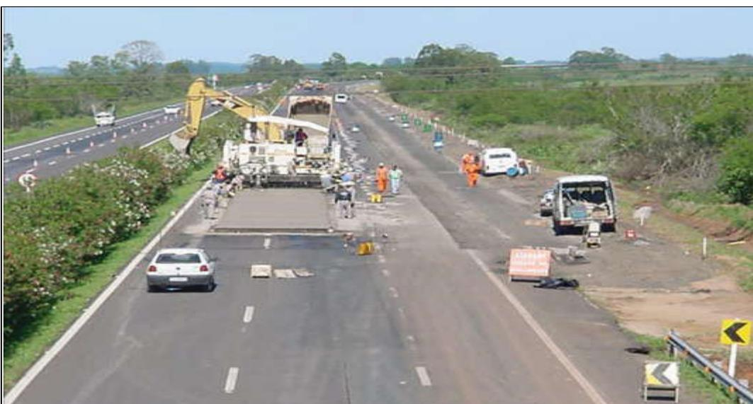
**63 – Nas faixas de tráfego, logo após, a execução de todos os procedimentos de reparos, será executada uma camada de concreto de 21 cm de espessura sobre o revestimento asfáltico existente, técnica conhecida como Whitetopping. (Fonte: Curso: CRG Engenharia/ABCP)**
