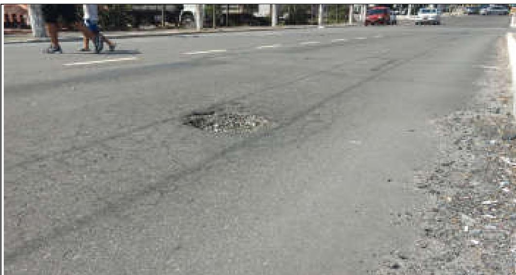
**58 – Caso ocorra nas faixas de tráfego, patologia do tipo “panela”, será reparada com Concreto Portland com resistência característica à compressão de 11 MPa. (Fonte: Imagens da Internet)**
