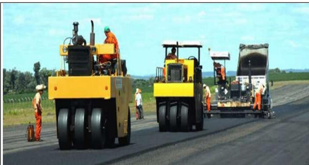
**62 – Execução de Concreto Asfáltico Usinado a Quente (CAUQ) a ser executado nos locais onde houver transição do pavimento de concreto para o revestimento asfáltico. (Fonte: Imagens da Internet)**
