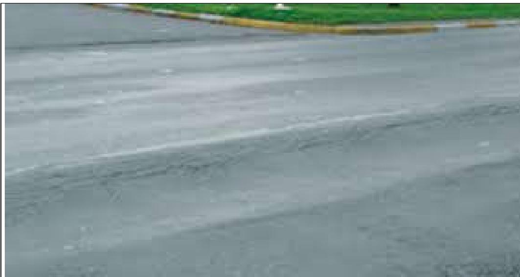
**56 – Exemplo de Patologia – Afundamento na Trilha de Rodas do revestimento asfáltico. (Fonte: Imagens da Internet)**
