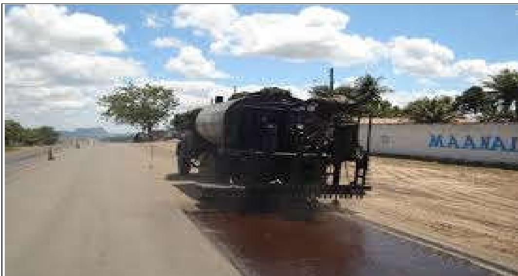
**61 – Antes da Execução do Concreto Asfáltico Usinado a Quente (CAUQ), a superfície deverá ser limpa através de vassouras mecânicas ou jatos de ar comprimido e proceder a aplicação do ligante betuminoso que neste caso será utilizada a Emulsão Asfáltica tipo RR-1C, a ser executado nos locais onde houver transição do pavimento de concreto para o revestimento asfáltico. (Fonte: Imagens da Internet)**
