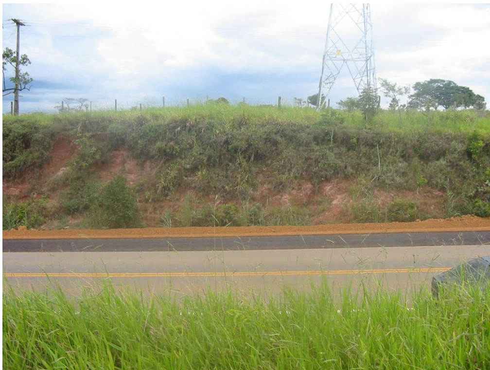
Foto 9.10 – Torre sobre a qual incidirá o talude de corte.
