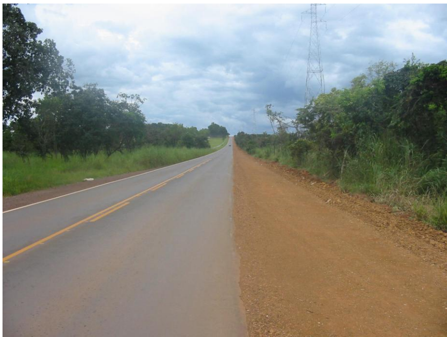
Foto 9.7- Obras do acostamento do lado direito.
