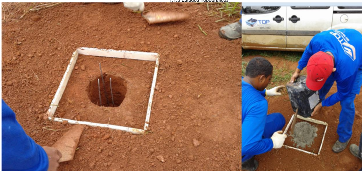
Fotografia 2 : Colocação da base protetora e enchimento da mesma. Fonte: Do autor (2013).
