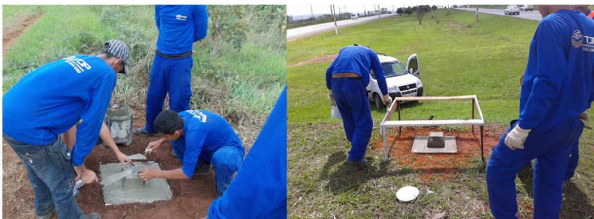
Fotografia 3 : Colocação do pino e vértice final implantado. Fonte: Do autor (2013).
