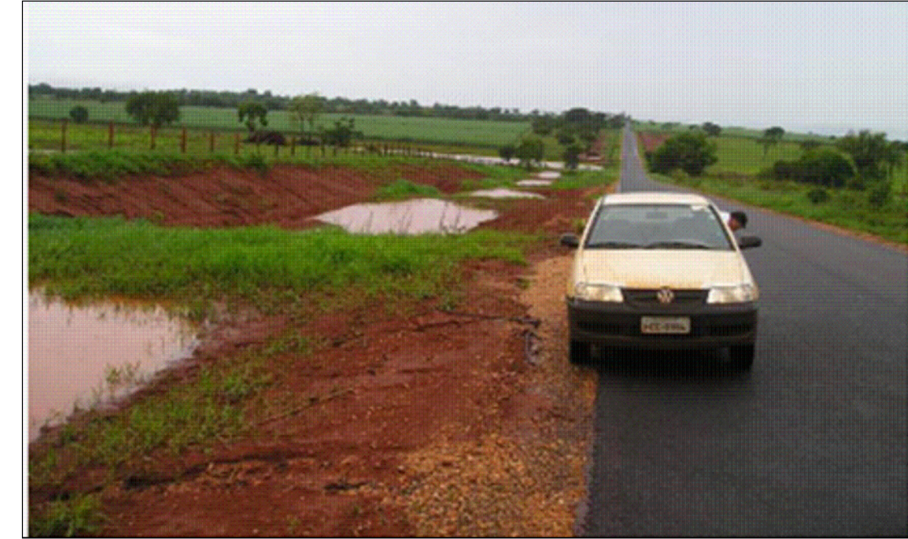
Micro bacias de acumulação e infiltração ao longo da estrada - Trecho Santo Antônio do Jacinto/Jacinto - MG (Foto Prof. Marcos Augusto Jabôr).
