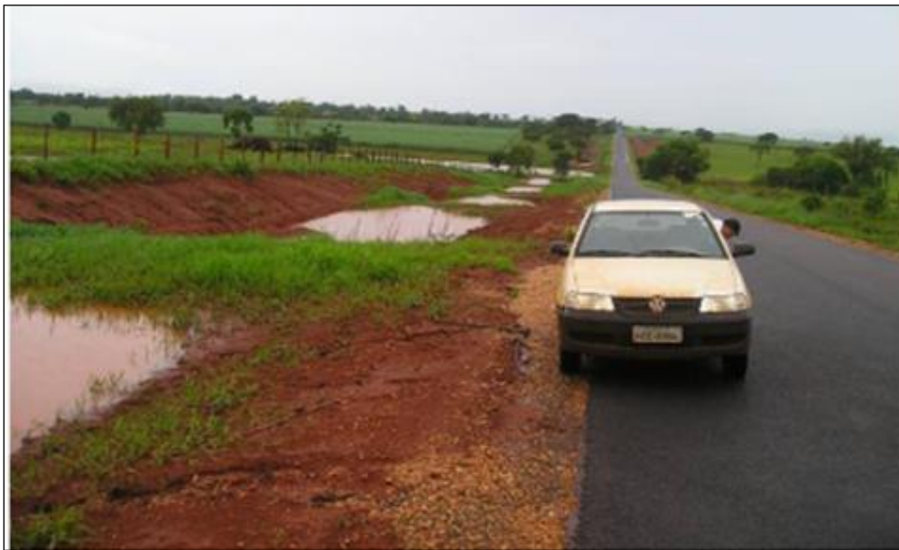
Figura 5. Micro bacias de acumulação e infiltração ao longo da estrada - Trecho Santo Antônio do Jacinto/Jacinto – MG (Foto Prof. Marcos Augusto Jabôr).
