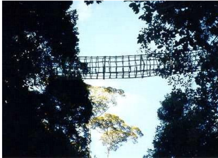
Figura 6 - Modelo de túnel de corda que permite a passagem dos animais arborícolas sobre rodovia, em trecho fragmentado.
