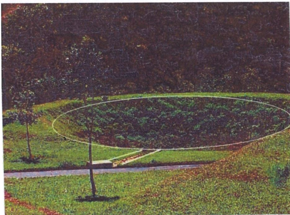
Figura 4 – Imagem da Bacia de Infiltração
