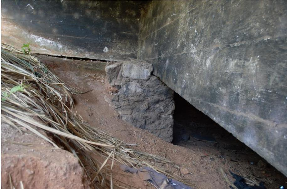
— **Foto 90** – Concreto disgregado com armadura exposta e corroída na cortina CT2 - Ponte 1 (lado final).
