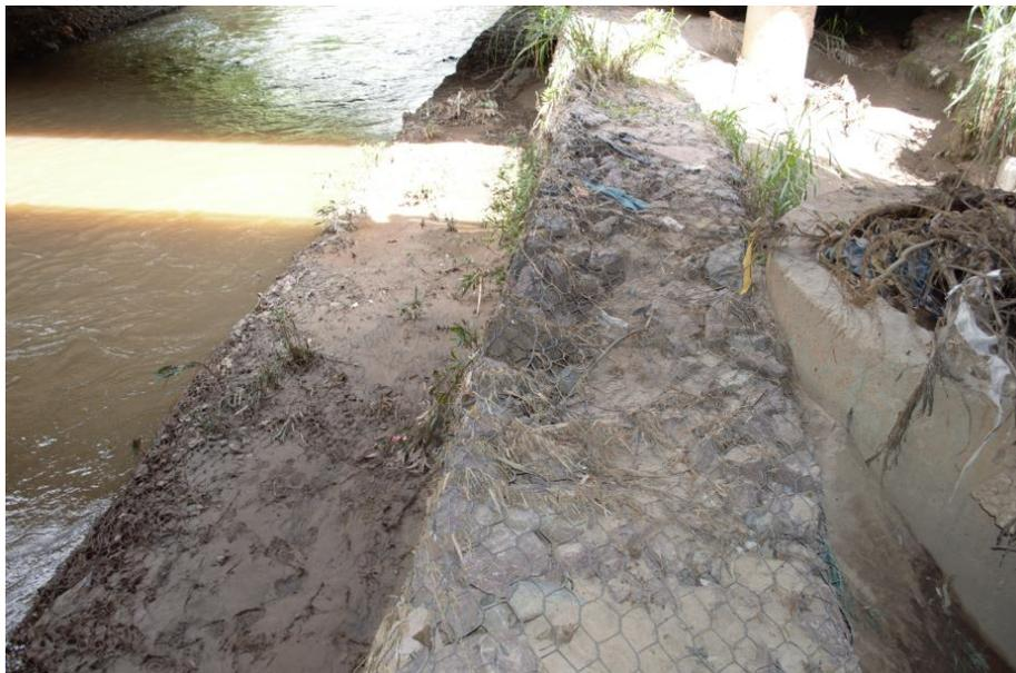
**Foto 53** – Acúmulo de sujeira e outros detritos junto ao pilar P4 (Ponte 1-lado final).
