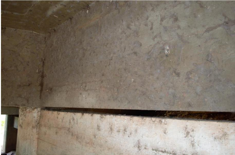
**Foto 66** – Concreto disgregado com armadura exposta e corroída na long. VL1(Ponte 1).
