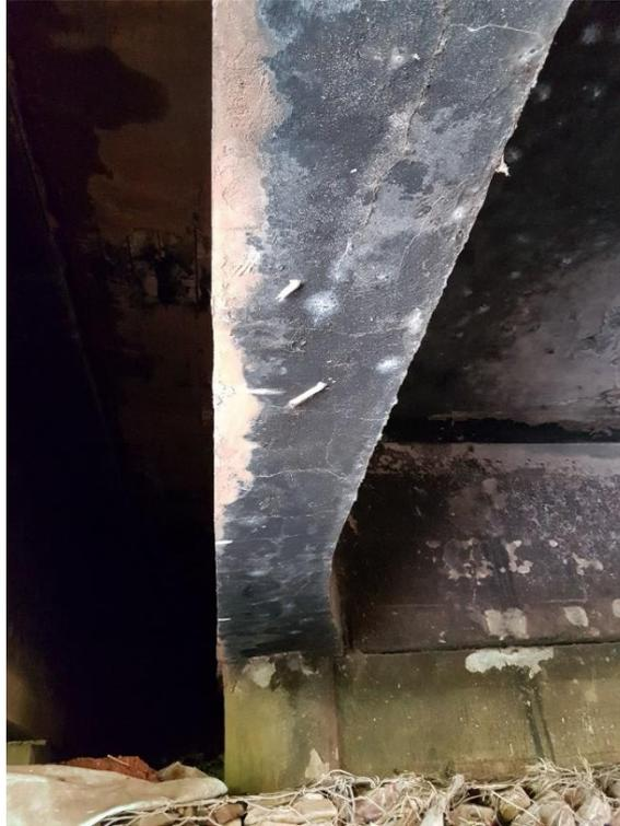
**Foto 70** – Detalhe do concreto disgregado com armadura exposta e corroída na long. VL1 (Ponte 1).
