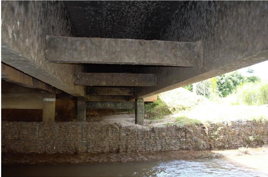
**Foto 26** – Vista Inferior do Alargamento 1. Destaque para apoios (lado final) e acúmulo de sujeira nos elementos.
