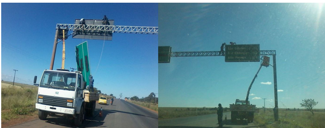
Troca de placas nas rodovias do SRDF
