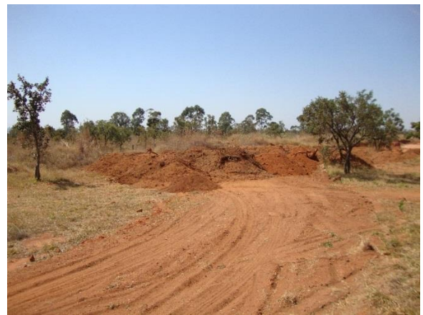
Figura 28. Deposição de resíduos sólidos na caixa de empréstimo.
