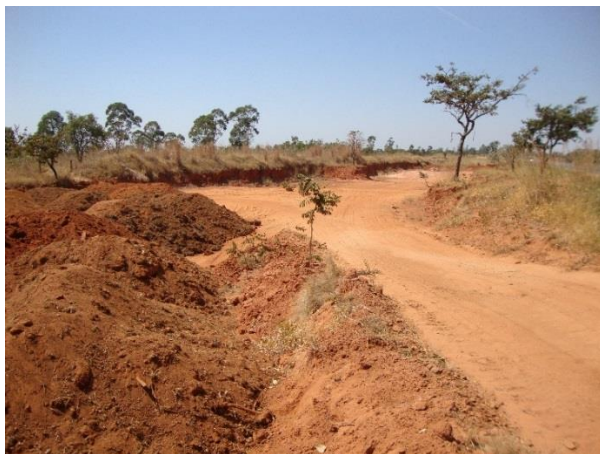
Figura 27. Deposição de resíduos sólidos na caixa de empréstimo.
