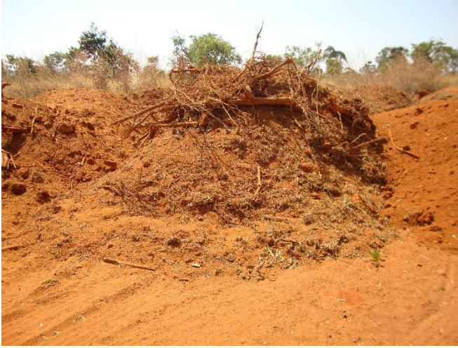
Figura 29. Restos de vegetação e solo orgânico depositados na caixa de empréstimo.
