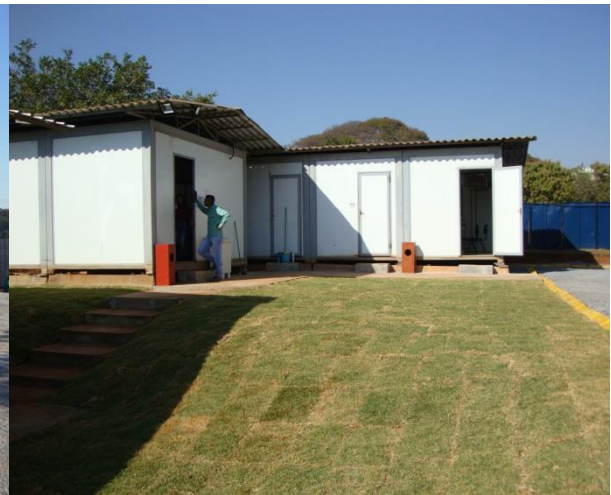
Figura 21. Vista das instalações do canteiro de obras.
