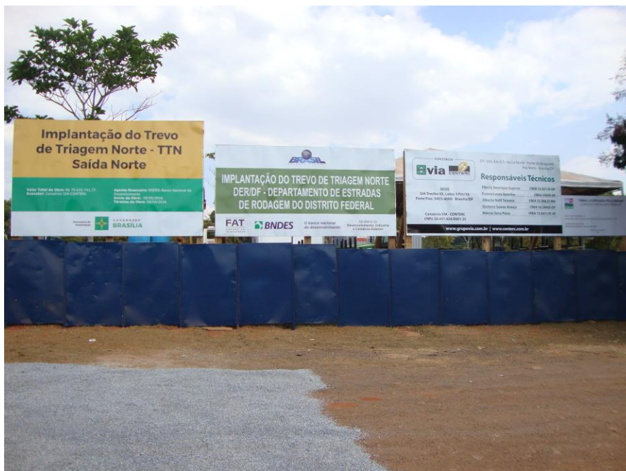
Figura 1. Placas de identificação do empreendimento dispostas na entrada do canteiro de obras.
