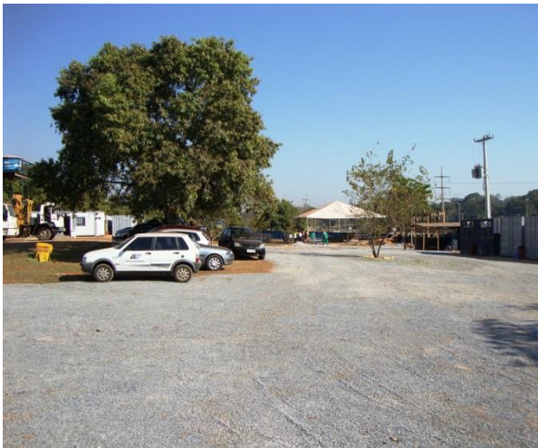
Figura 20. Vista geral do canteiro de obras.
