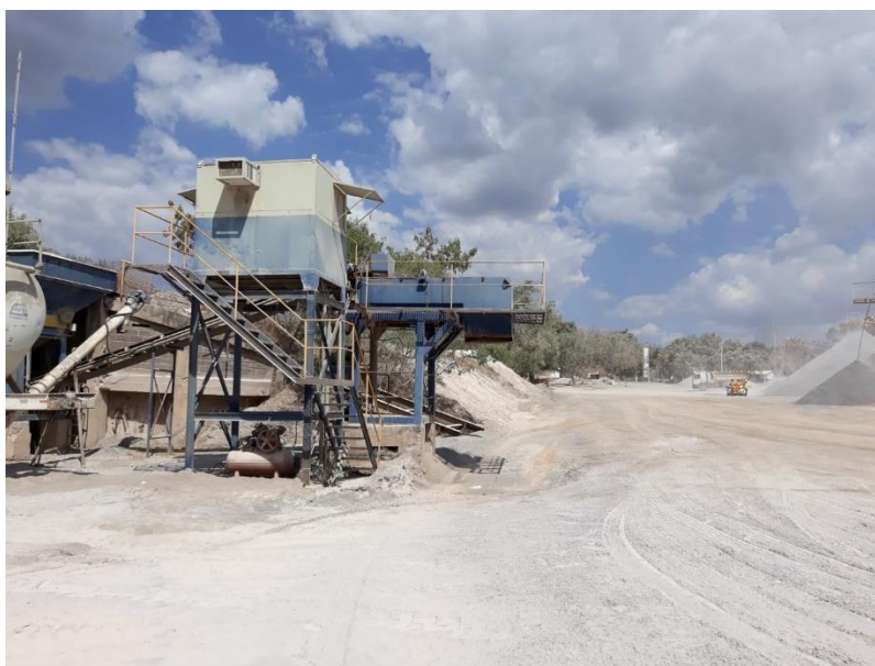
Figura 31 – Usina localizada na Pedreira Contagem
