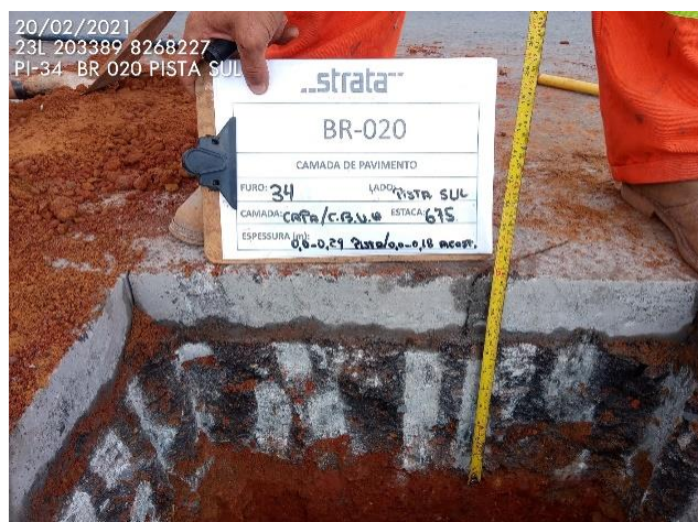
Figura 49 – Revestimento espesso – Poço de inspeção 34.
