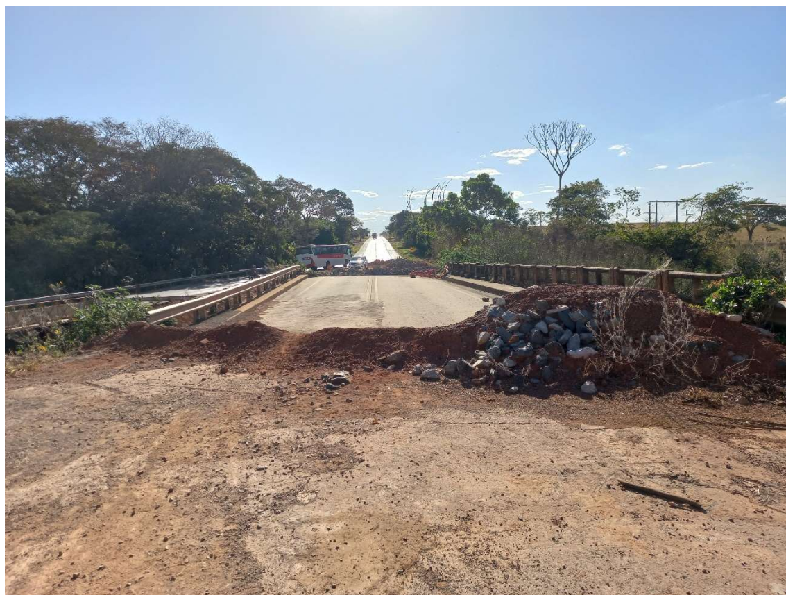
Fotografia 21 – vista noroeste da ponte interditada a ser demolida.
