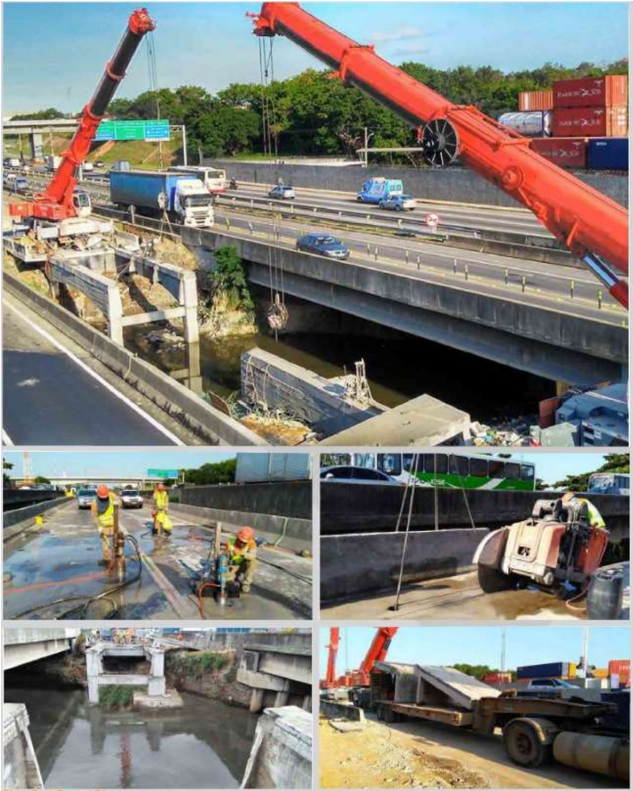
Imagens 10 – Demolição controlada com uso de fio e serra de corte auxiliado por equipamento de içamento e transporte. Fonte: Nova América perfurações e cortes em concreto
