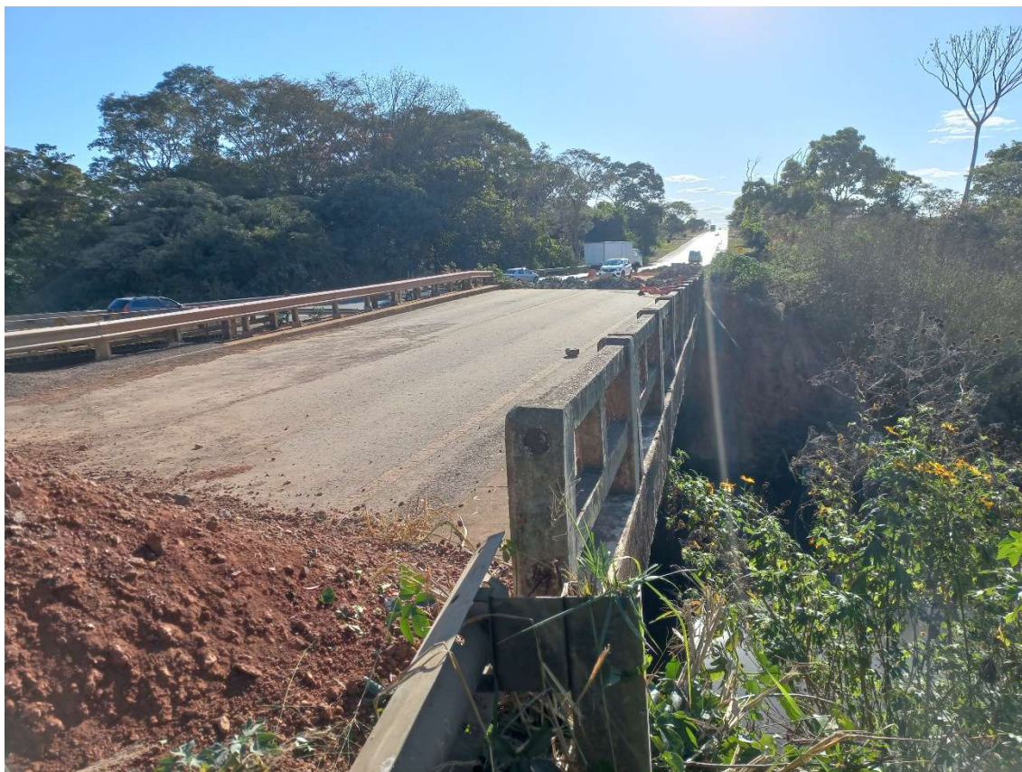
Fotografia 23– vista noroeste da ponte interditada a ser demolida.
