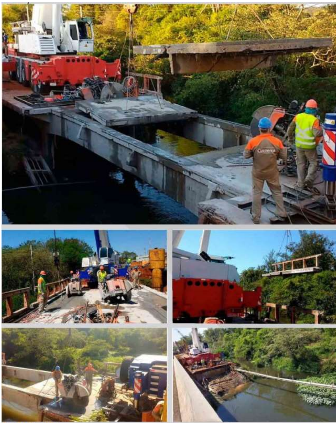
Imagens 09 – Demolição controlada com uso de fio e serra de corte auxiliado por equipamento de içamento. Fonte: Nova América perfurações e cortes em concreto
