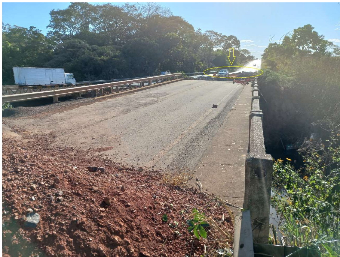
Fotografia 12 - Indicando a área para armazenagem de resíduos sólidos
