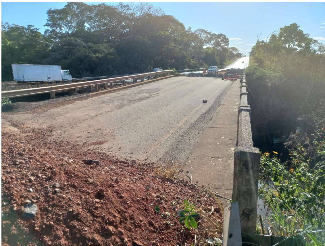
Fotografia 22 – vista noroeste da ponte interditada a ser demolida.
