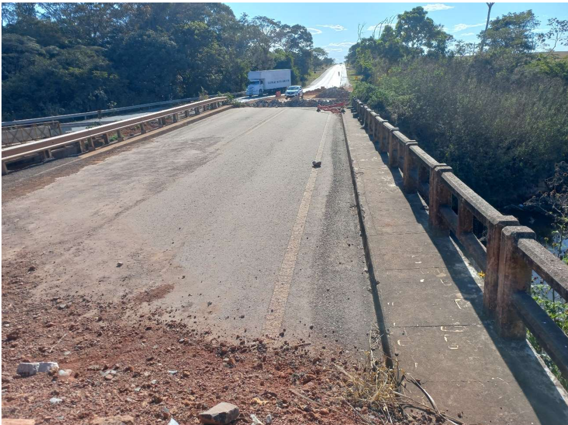
Fotografia 17 – vista noroeste da ponte interdita a ser demolida.
