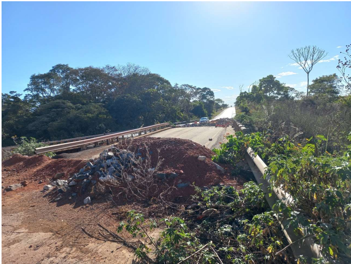
Fotografia 18 – vista noroeste da ponte interditada a ser demolida.
