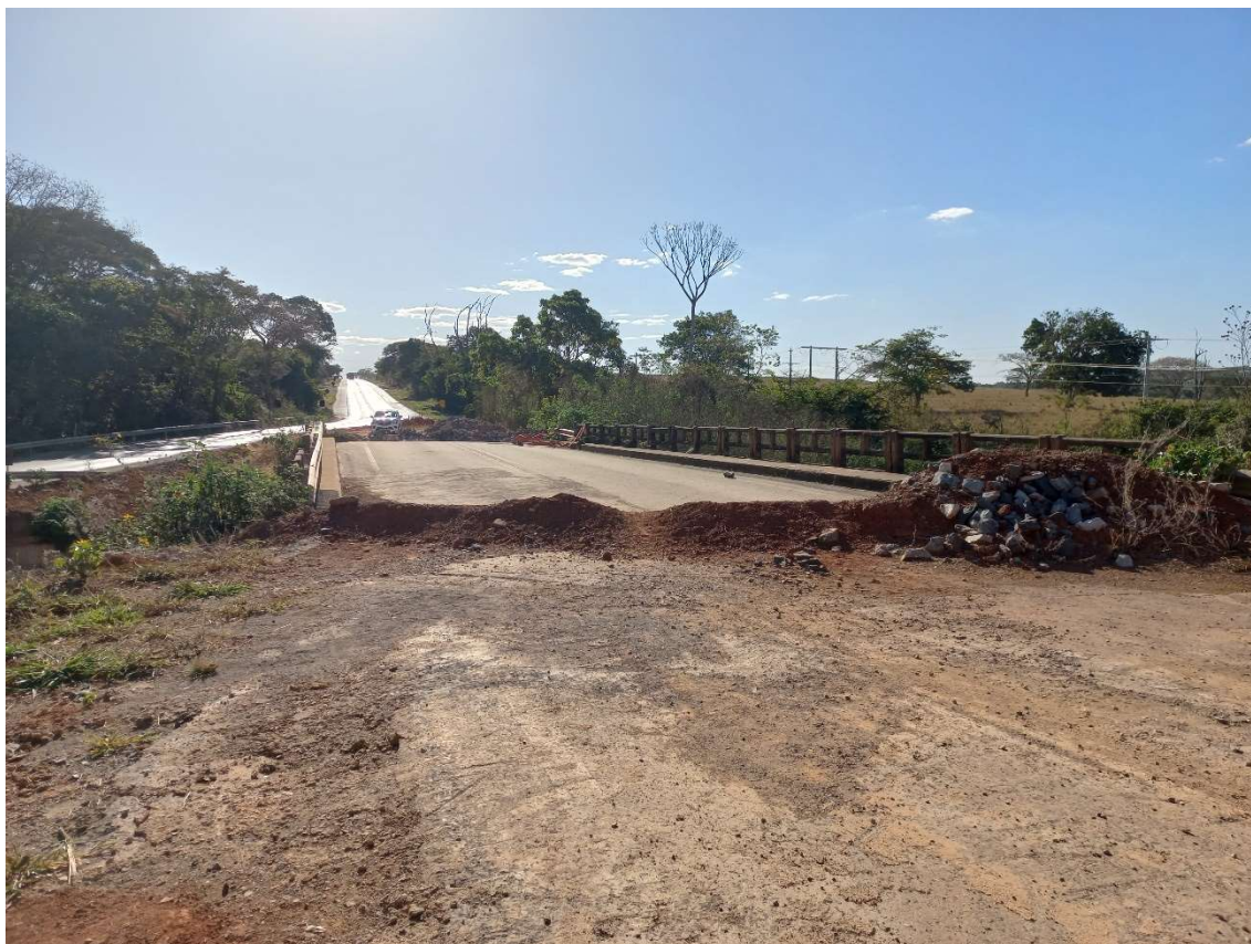
Fotografia 19 – vista noroeste da ponte interditada a ser demolida.
