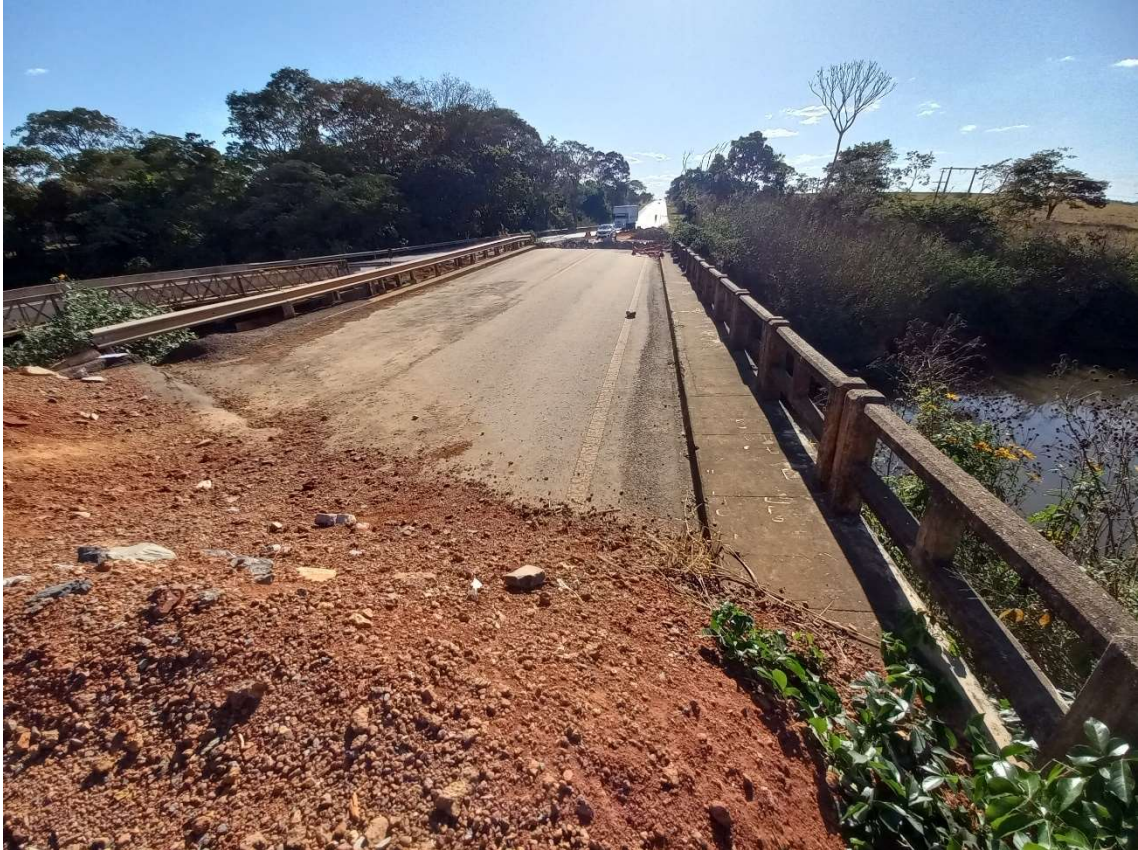
Fotografia 16 – vista noroeste da ponte interdita a ser demolida.
