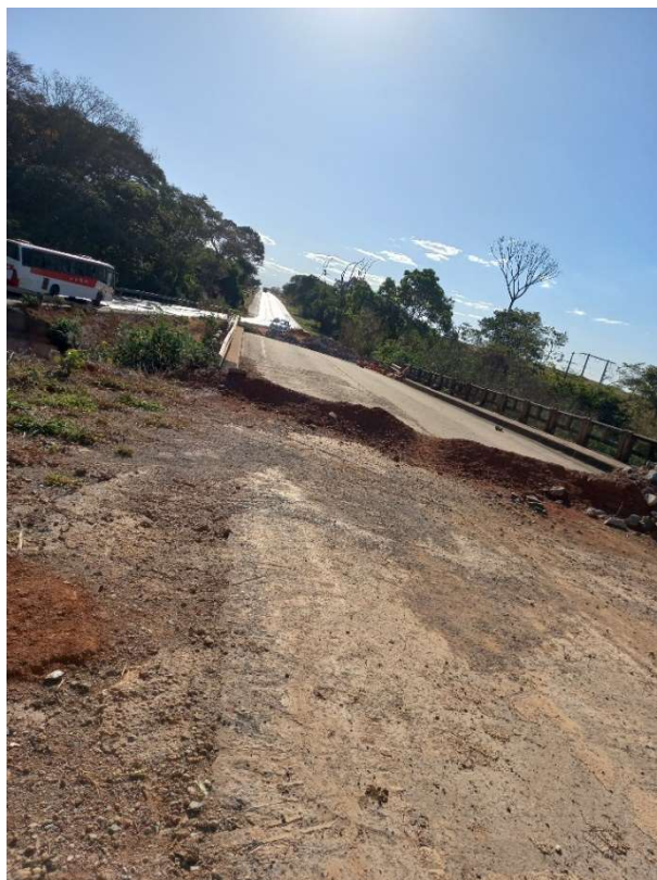
Fotografia 20 – vista noroeste da ponte interditada a ser demolida.
