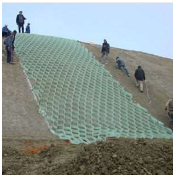
Figura 2 - Aplicação de geogrelha em taludes.
