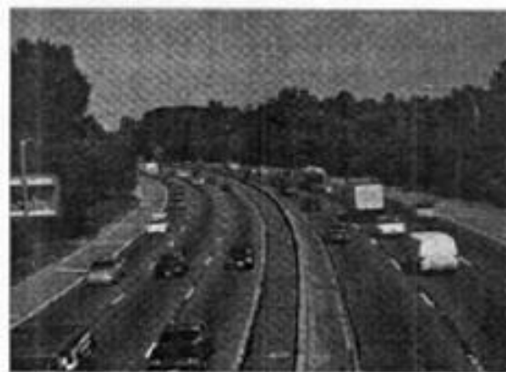
Nível de serviço "D"
