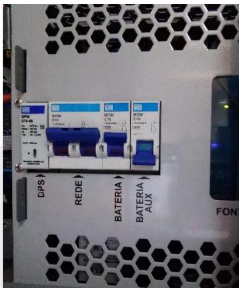
A conexão de energia se dá, após o ramal de entrada e medição diretamente pelos bornes inferiores do disjuntor bipolar MDWB10, conforme imagem abaixo. Para o caso de um sistema monofásico utilizar como fase a cor cinza e neutro a cor azul. Para um sistema bifásico a regra não se aplica, porém deve-se observar a tensão máxima do sistema de acordo com a tabela de especificações.
