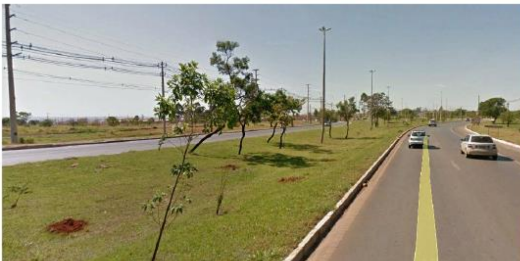
Figura 7 : DF-001 – Trecho com duas faixas de rolamento em cada sentido. Fonte – Google Street View
