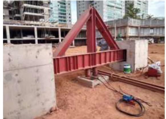
Foto 02 – Detalhe do Bloco de Ancoragem
