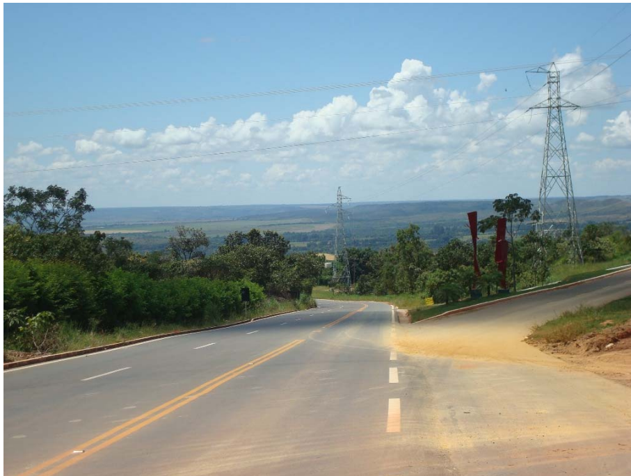
Foto 3 – Declive com curva acentuada à esquerda, sentido Jardim ABC
