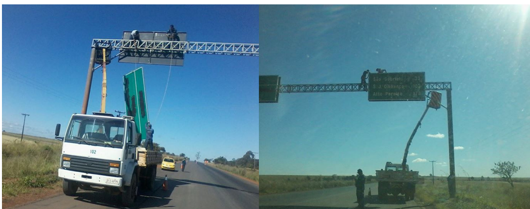
Troca de placas nas rodovias do SRDF
