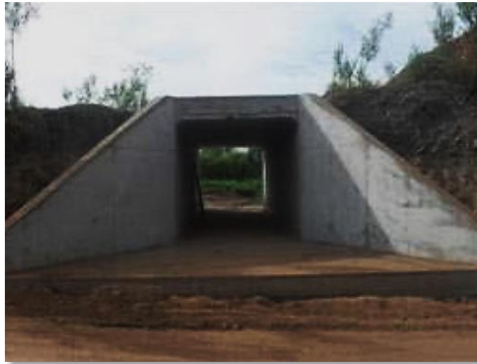
Figura 03: Foto mostrando passagem de fauna tipo galeria de 2x2 metros.
