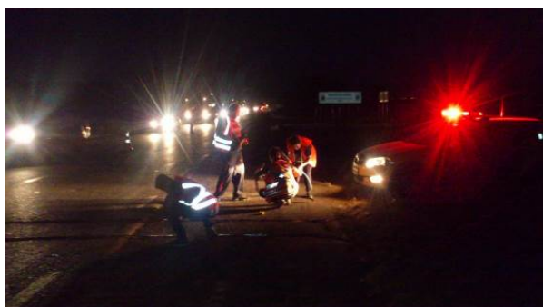
foto 2 (Rodovia DF-001) – Instalação de equipamento com apoio do DER/DF
