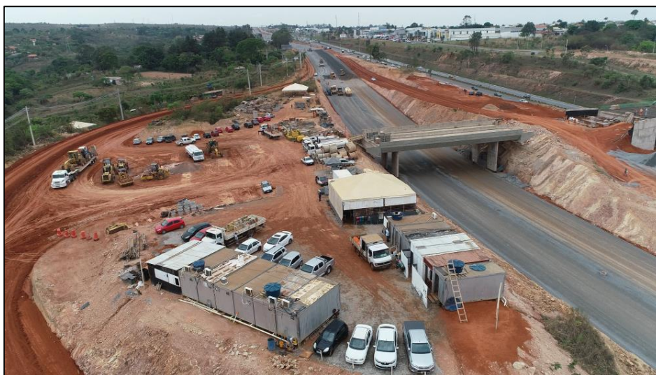
Figura 5. Canteiro de obras da empresa executora das obras do Lote 2.
