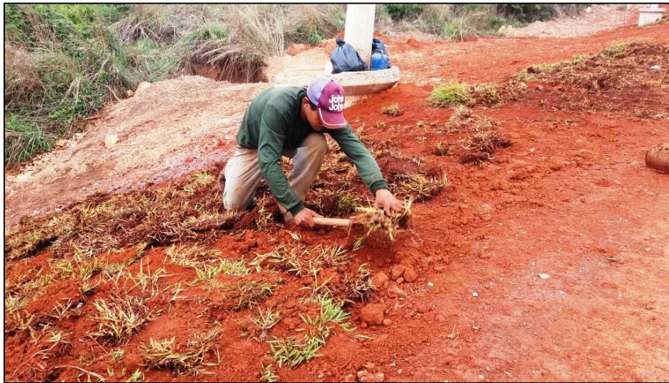
Figura 8. Plantio de grama nos taludes.
