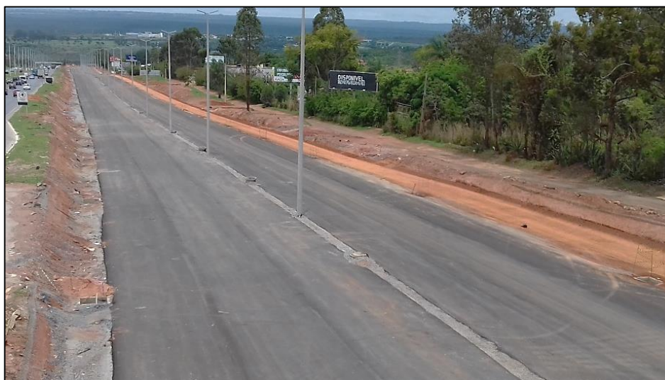
Figura 3. Mesmo trecho já com a capa asfáltica e sistema de drenagem pluvial em 2018.
