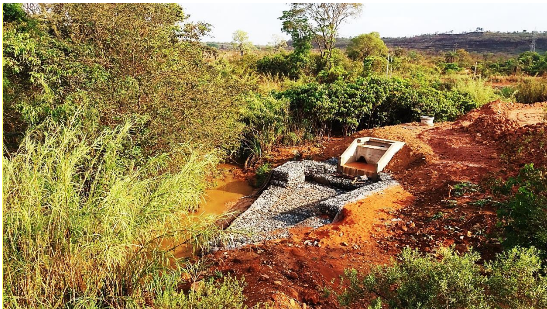
Figura 12. Ponto de lançamento da rede de drenagem no córrego Açude.
