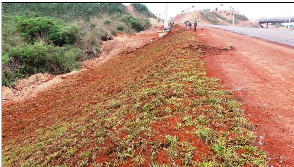
Figura 7. Plantio de grama nos taludes.
