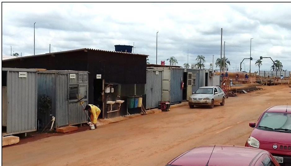
Figura 4. Canteiro de obras da empresa executora das obras do Lote 1.
